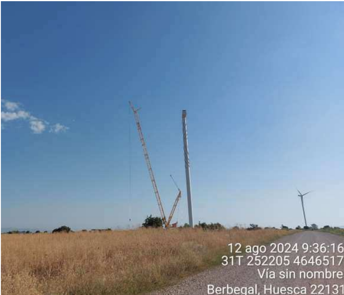
Imagen 1. Posición SC4-02 con la grúa preparada para el montaje.
