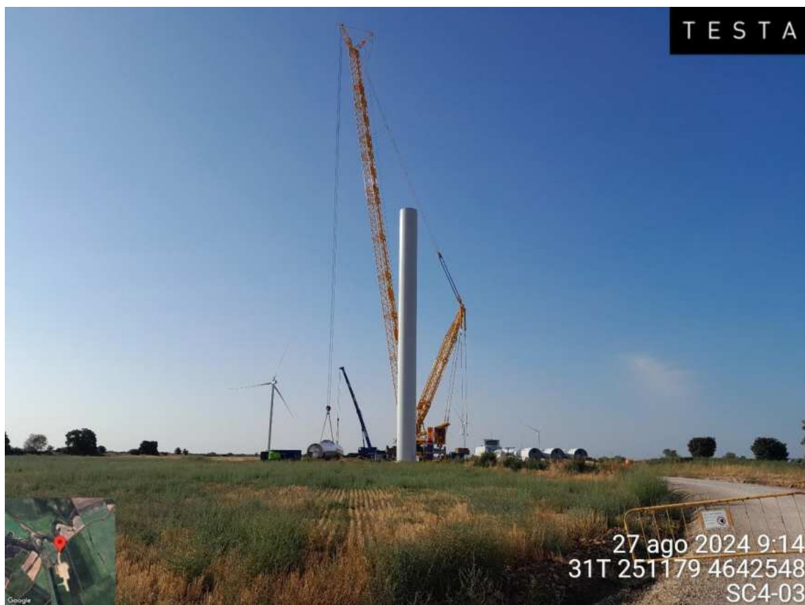
Imagen 2. Montaje de Aerogenerador en la posición SC4-03
