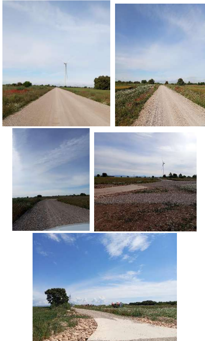
Fotografías 2 a 6 Estado de las viales
