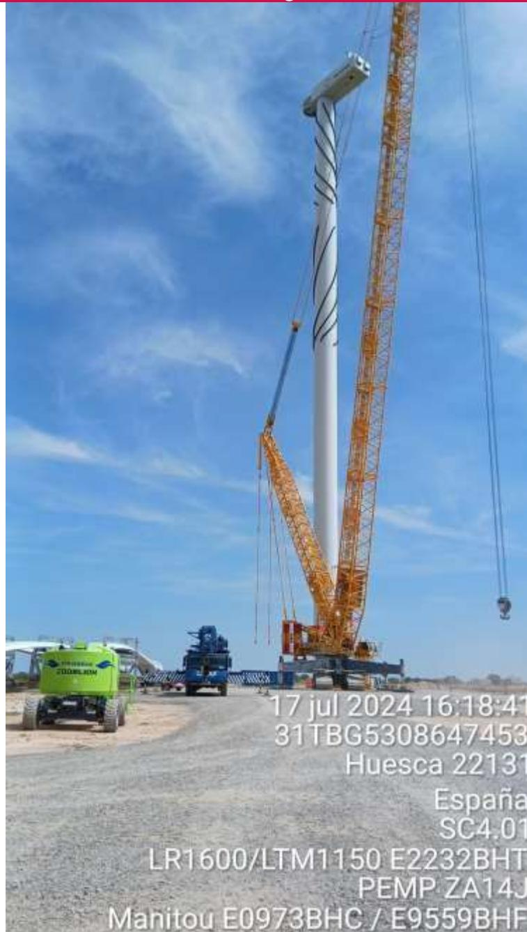
Imagen 1. SC4.01 Montaje principal de palas.
