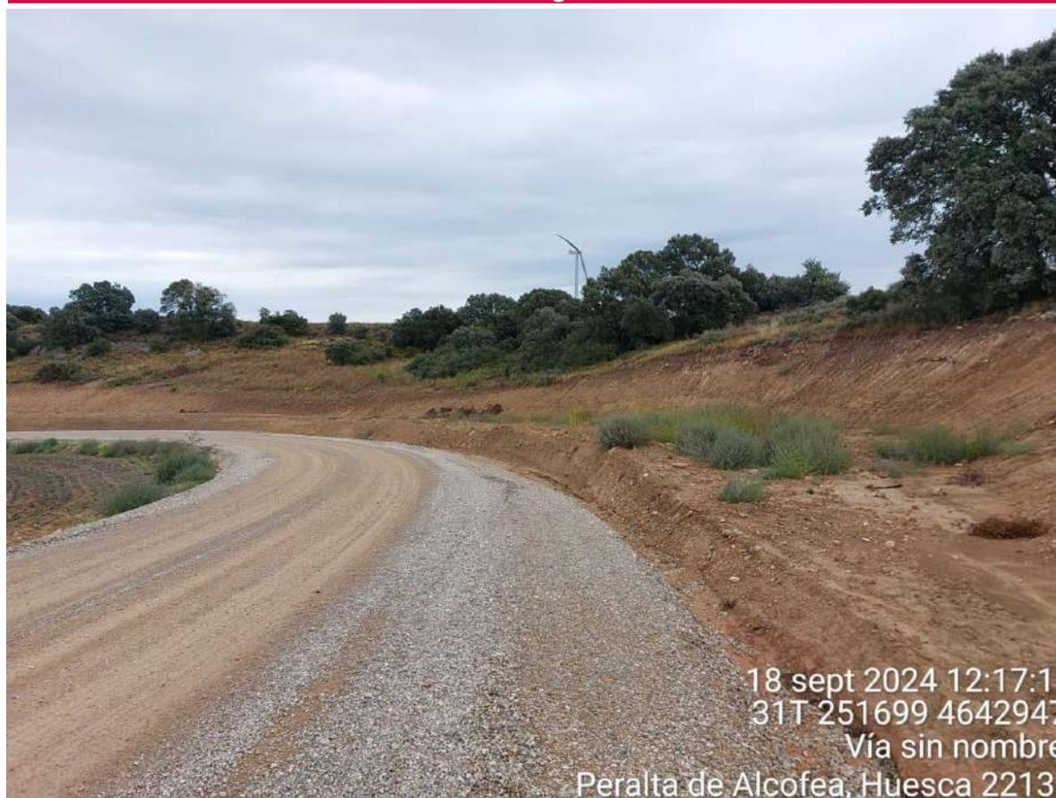
Imagen 1. Zona en la que se deberá realizar una descompactación y una revegetación.
