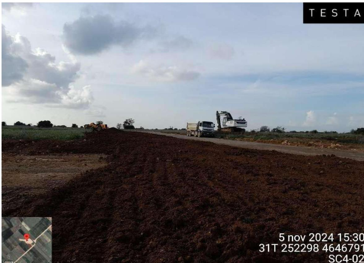
Imagen 2. Extendido de tierra vegetal durante los trabajos de restauración en la posición SC4-02
