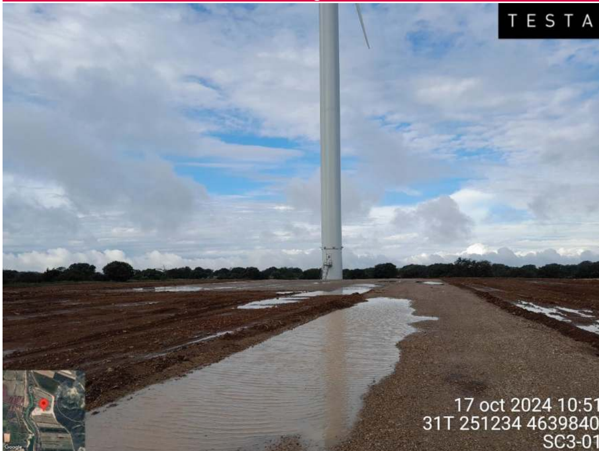
Imagen 1. Restauración de la posición SC3-01
