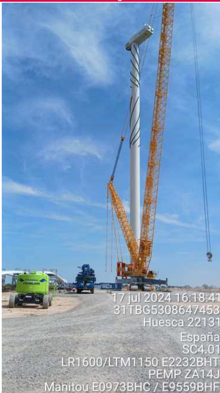
Imagen 1. SC4.01 Montaje principal de palas.
