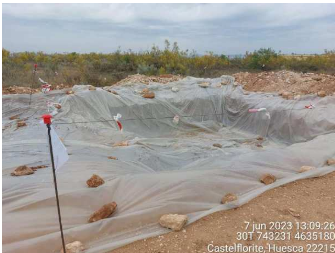
Imagen 3. Pozo de lavado en buenas condiciones.
