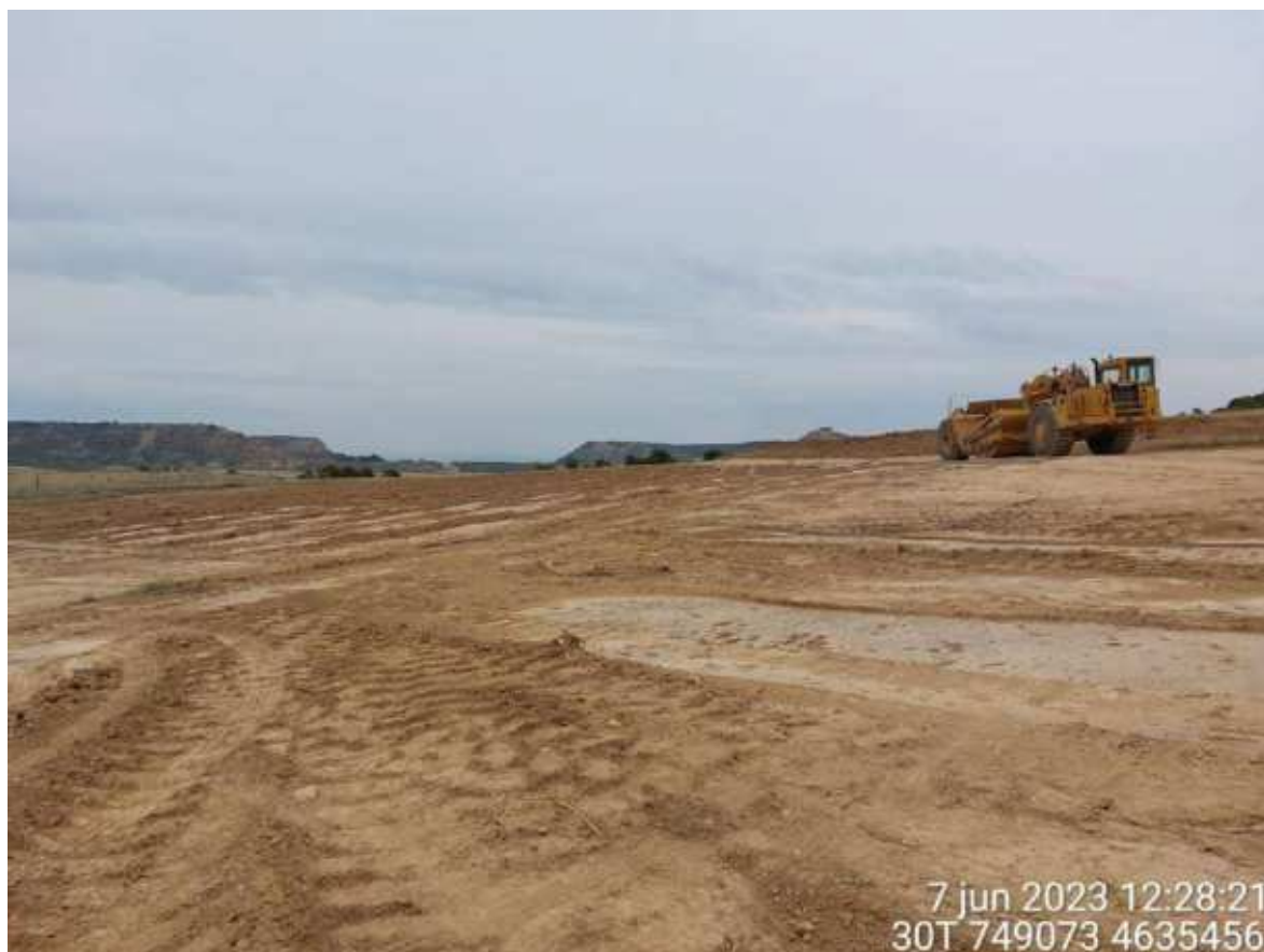
Imagen 1. Desbroce en SCI-01.
