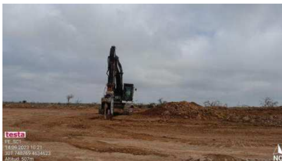
Maquinaria en zanja de evacuación en SC1
