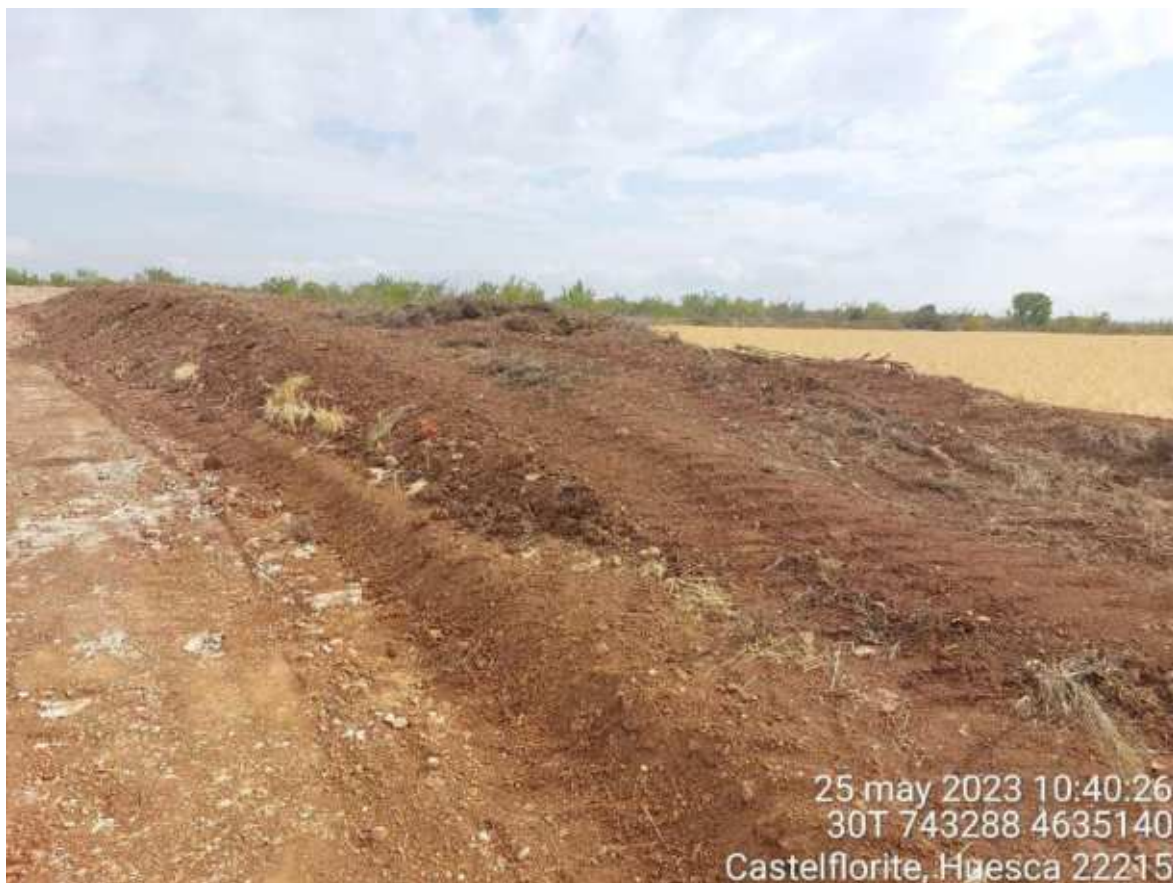
Imagen 3. Cordón de tierra vegetal acopiado correctamente.
