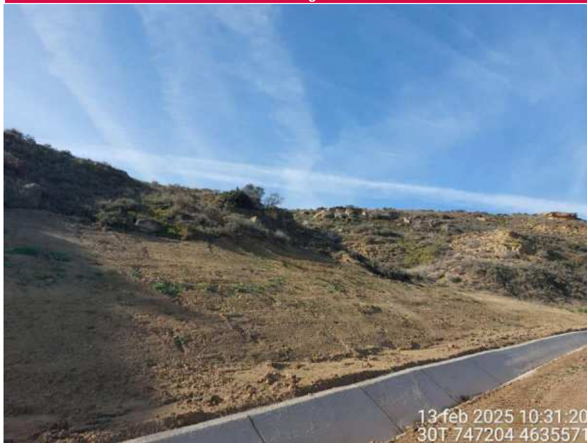
Imagen 1. Talud en SCA hidrosechado.
