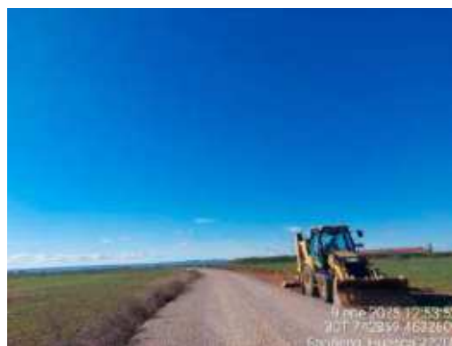
Maquinaria realizando excavaciones para cunetas
