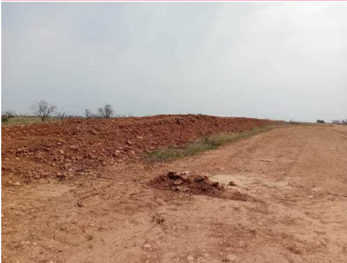
Imagen 3. Separación de la tierra vegetal realizada del modo correcto en SC1.
