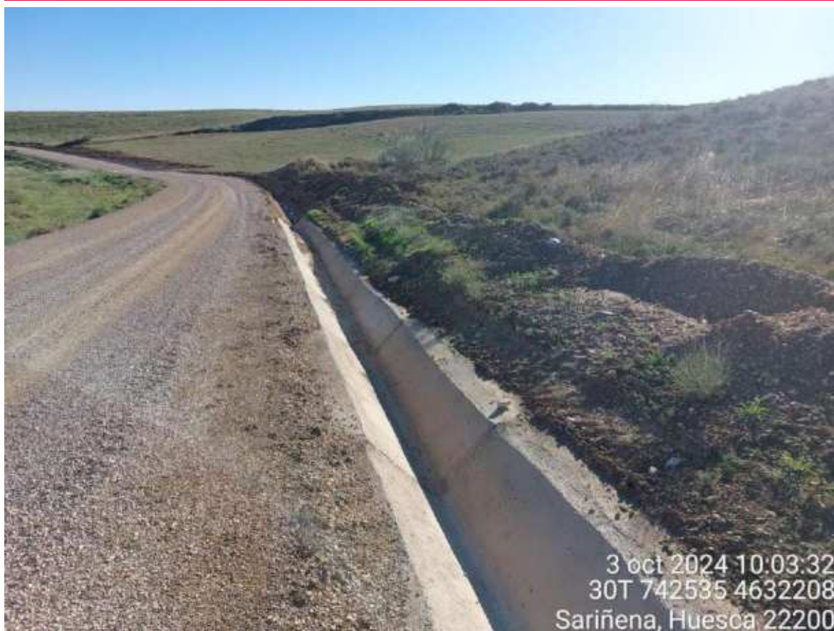
Imagen 1. Realización y hormigonado de cunetas en PE Santa Cruz Ampliación.
