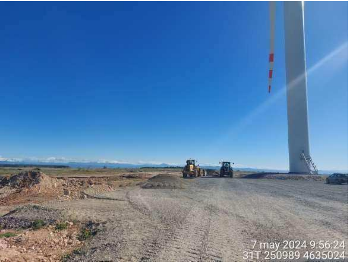
Imagen 1. Comienzo de trabajos de restauración en SC1-01.
