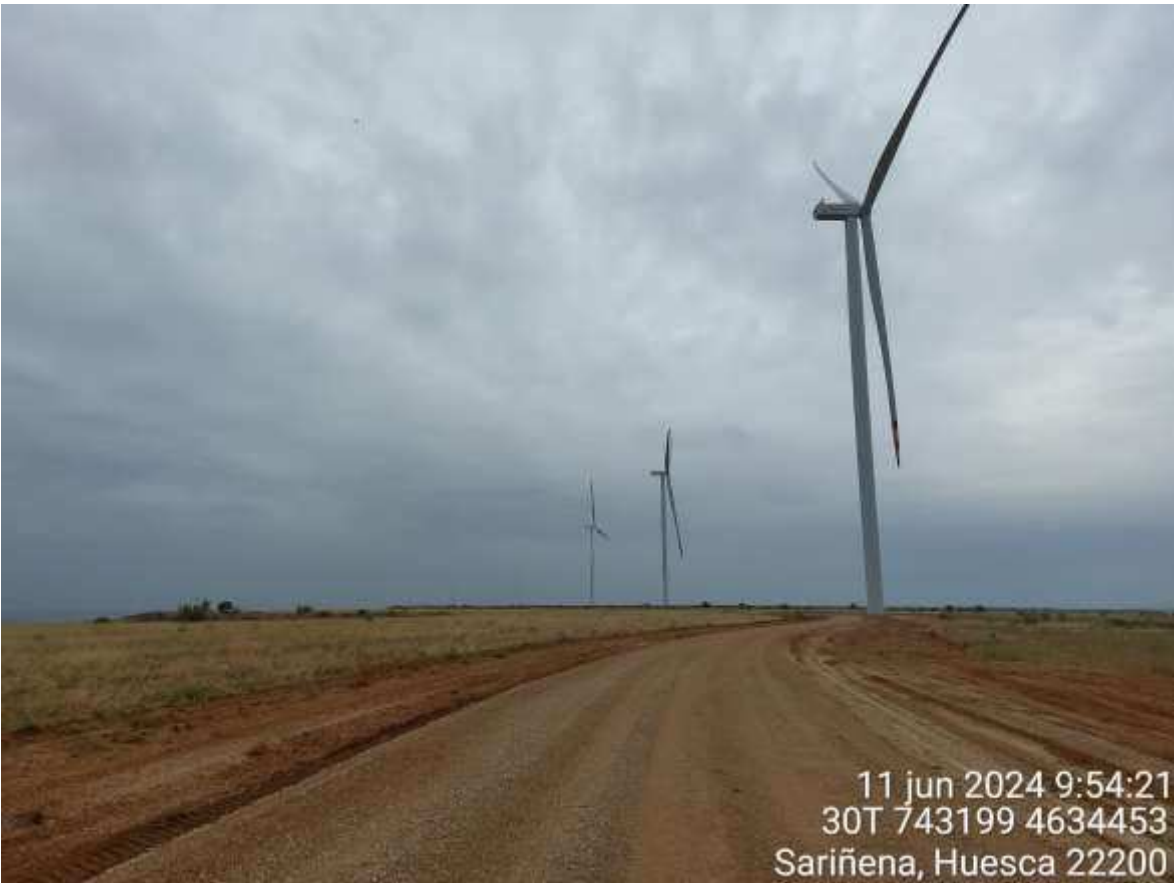
Imagen 1. Vista de SC2 tras la restauración ambiental y los trabajos sobre el vial.
