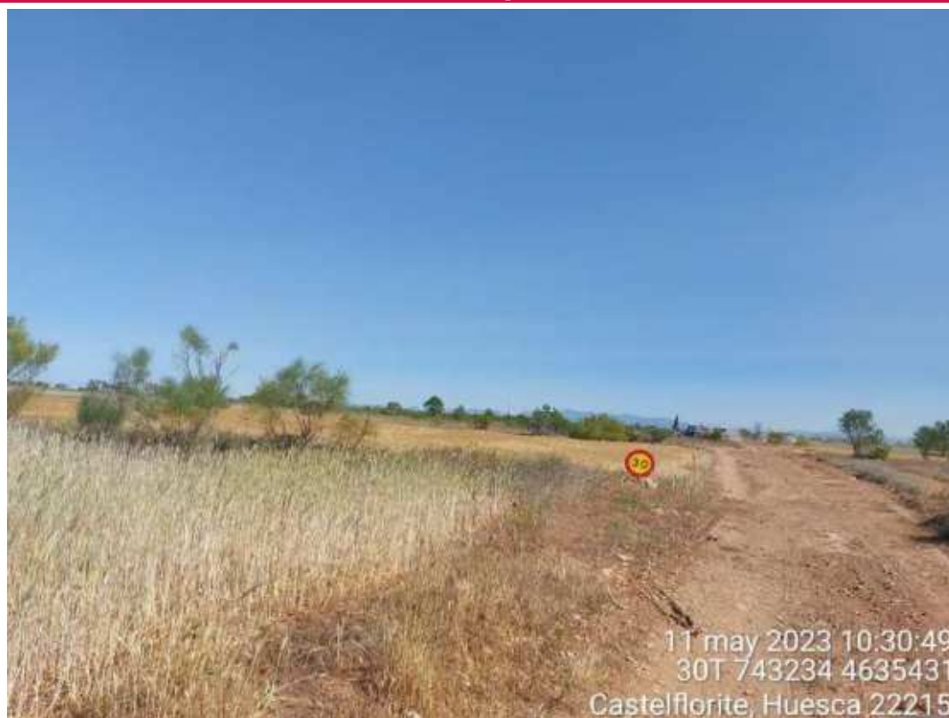
Imagen 1. Señalización de máxima velocidad en obra.
