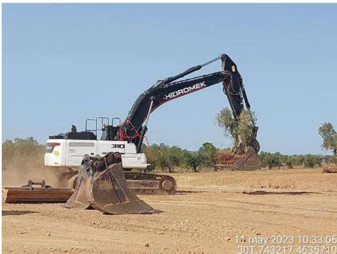
Imagen 4. Maquinaria transportando ejemplares arbóreos tras su arranque.
