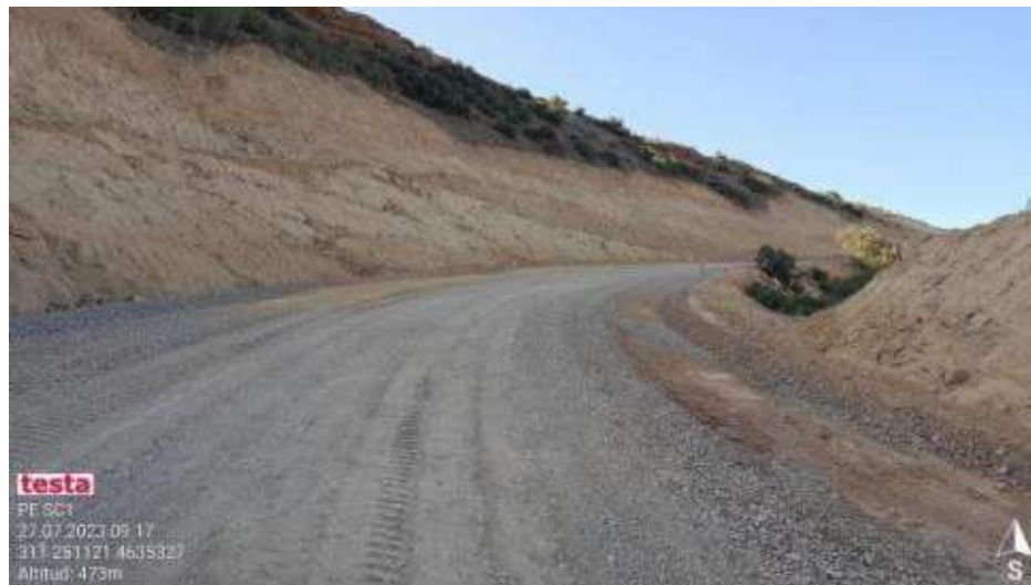
Adecuación del vial de subida a SC1
