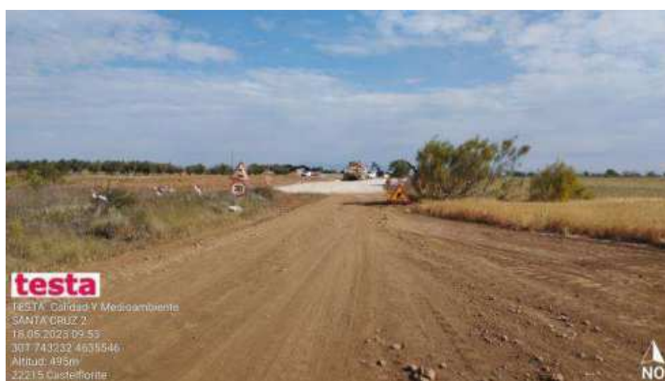
Apertura de viales y plataformas.
