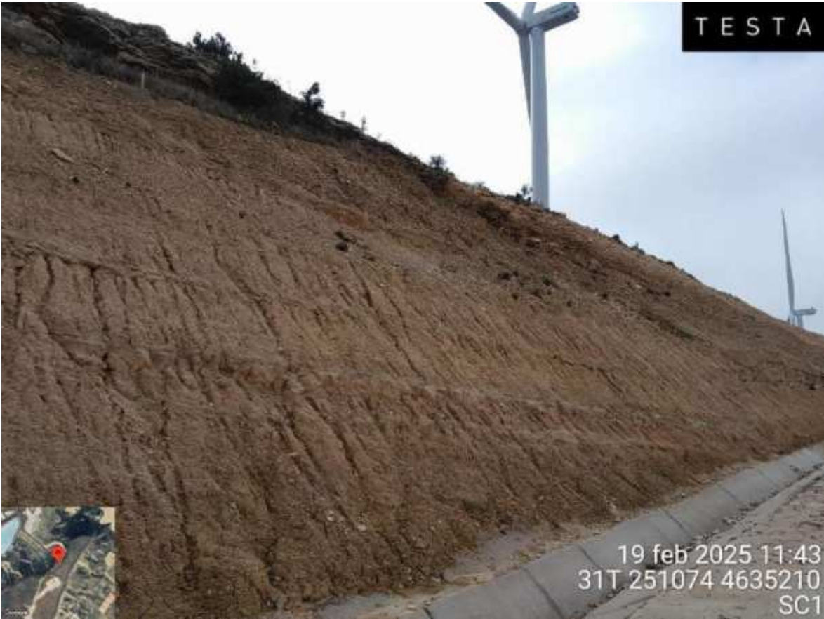
Imagen 1. Talud hidrosechado en SC1
