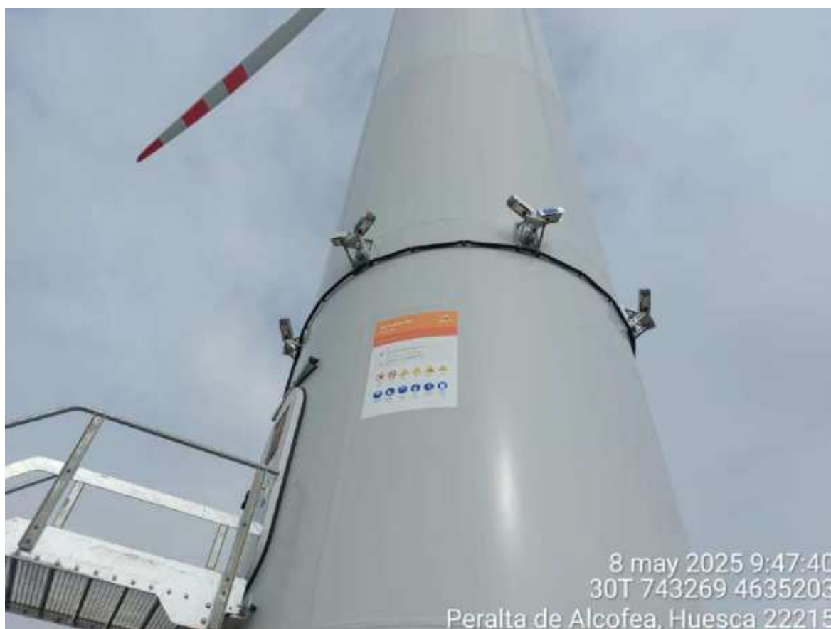
Imagen 2. Cámaras del sistema 3D Observer de SC2-02.
