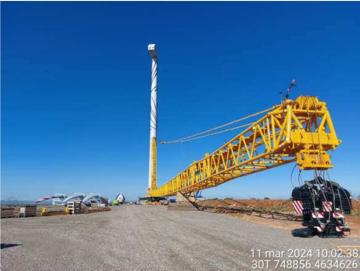
Imagen 1. Montaje de SC1-03.
