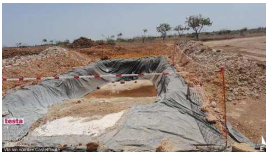
Adecuación de pozos de lavado en SC1
