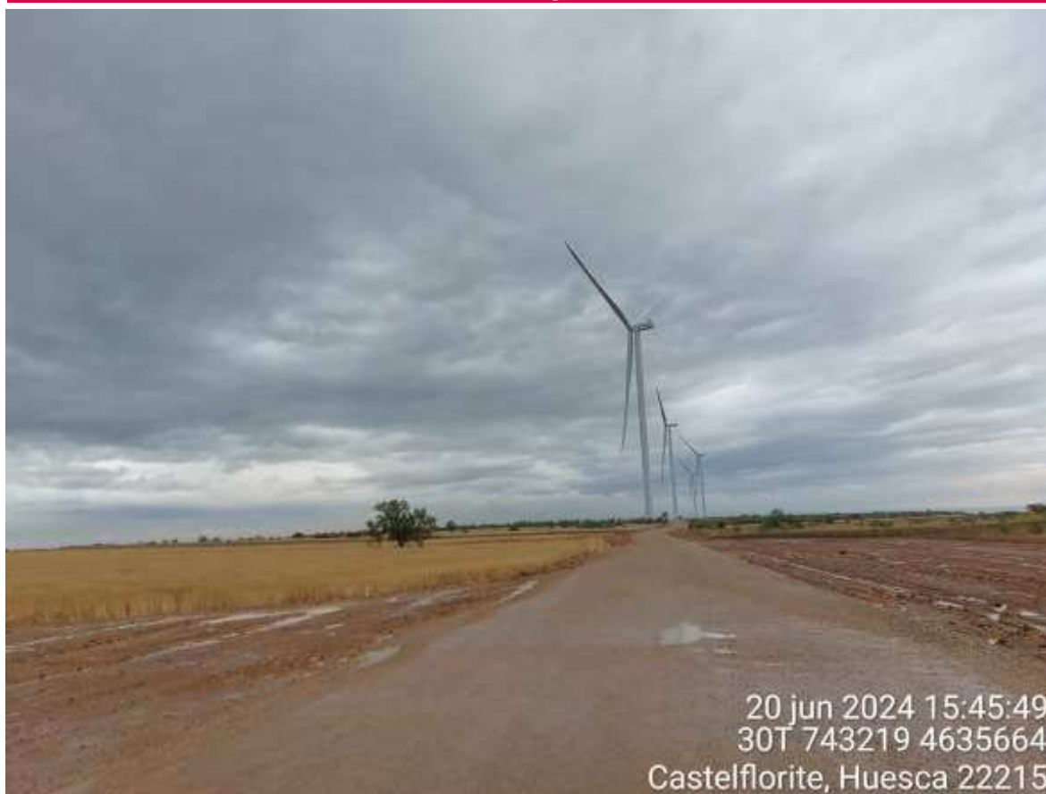
Imagen 1. Vista de SC2 y SCA tras restauración ambiental.
