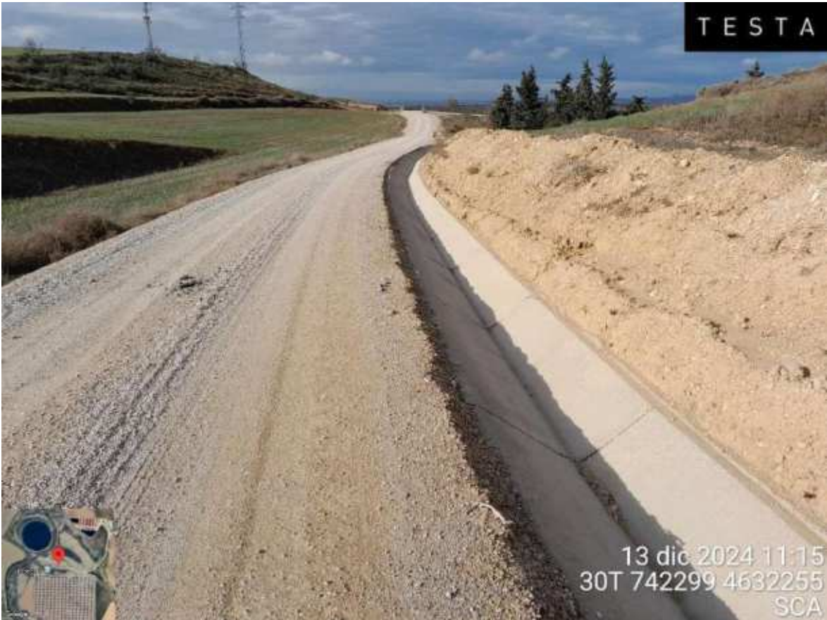
Imagen 1. Cuneta en el vial de entrada
