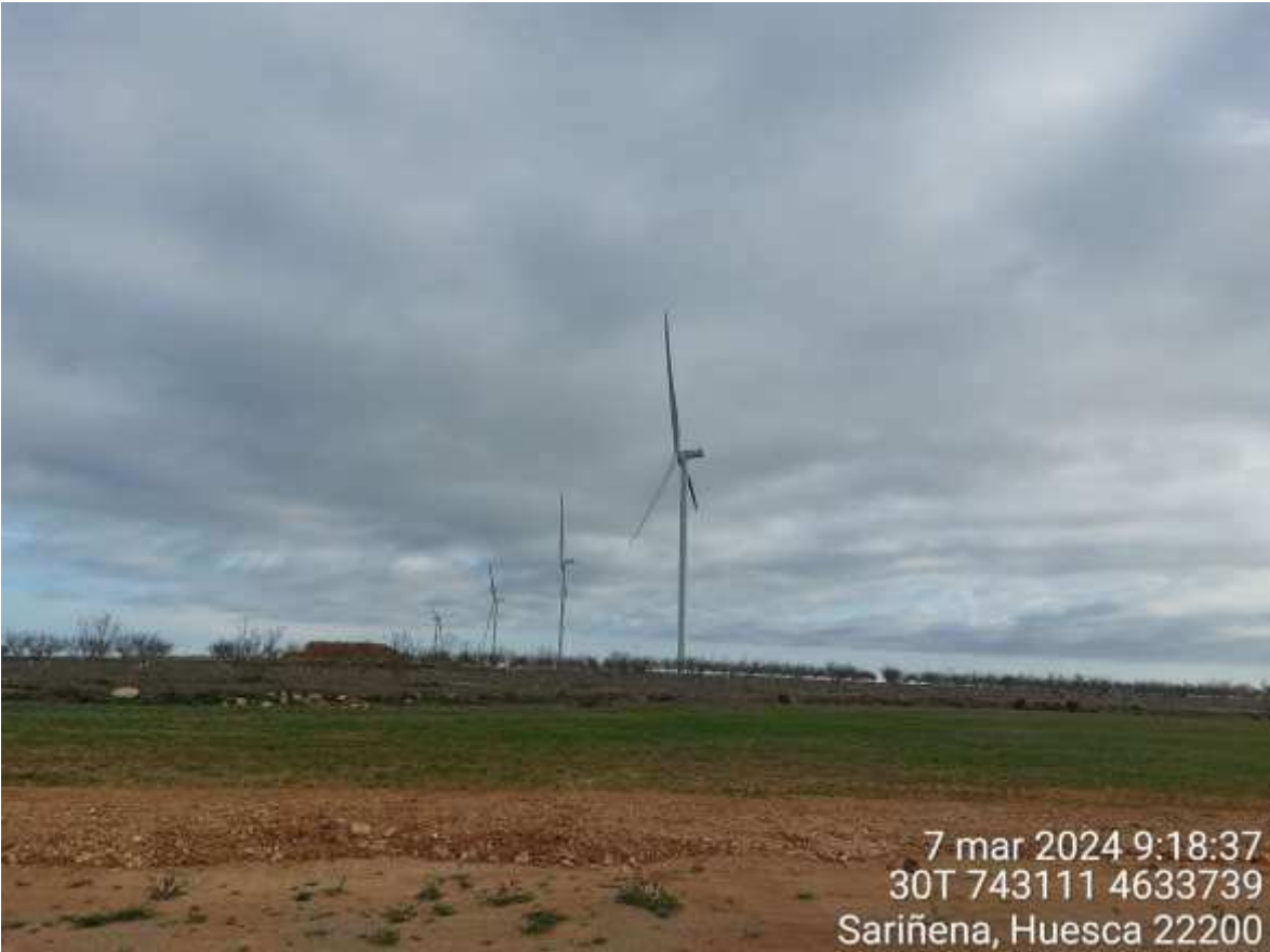
Imagen 1. Parques eólicos SC2 y SCA.
