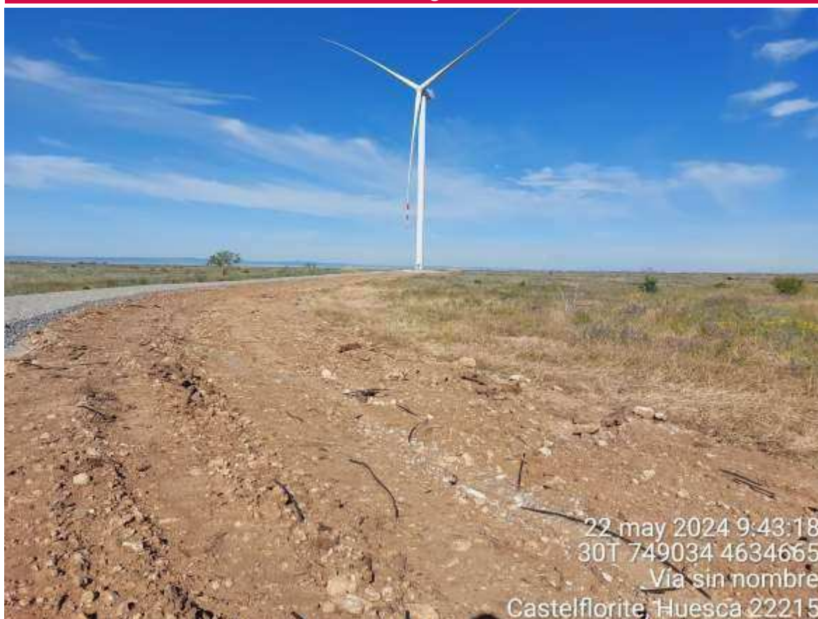
Imagen 1. Vial entre SC1-03 y SC1-02 restaurado.
