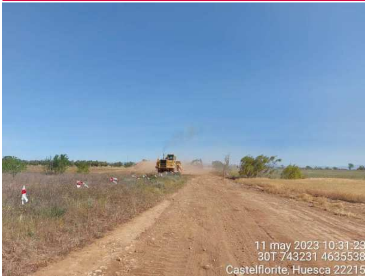
Imagen 3. Maquinaria trabajando en SCII.
