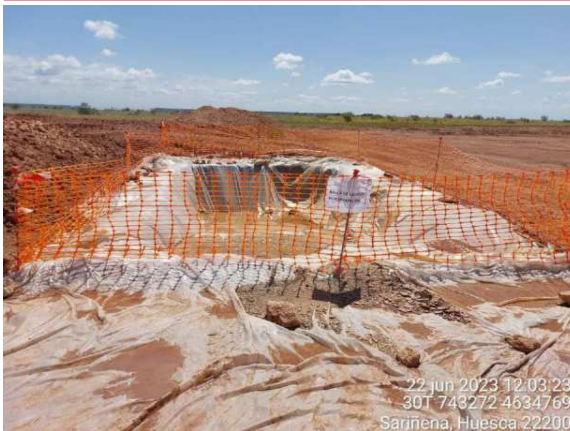
Imagen 1. Pozo de lavado en buenas condiciones
