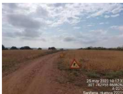
Señal limitación velocidad en obra
