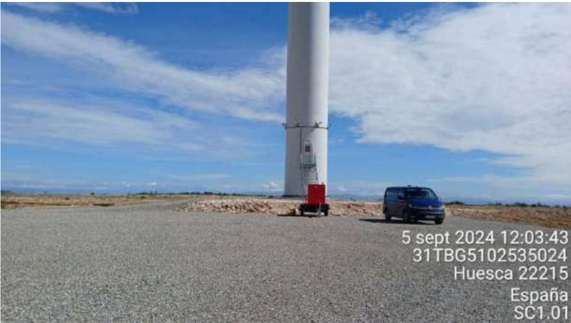
Imagen 1. Trabajos internos en SC1-01.
