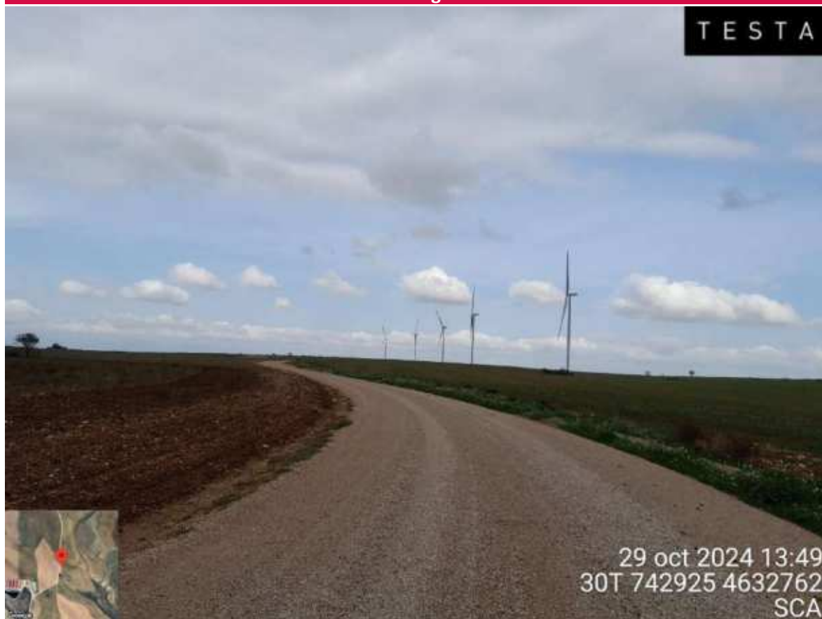
Imagen 1. Imagen panorámica de los 5 aerogeneradores de SCA
