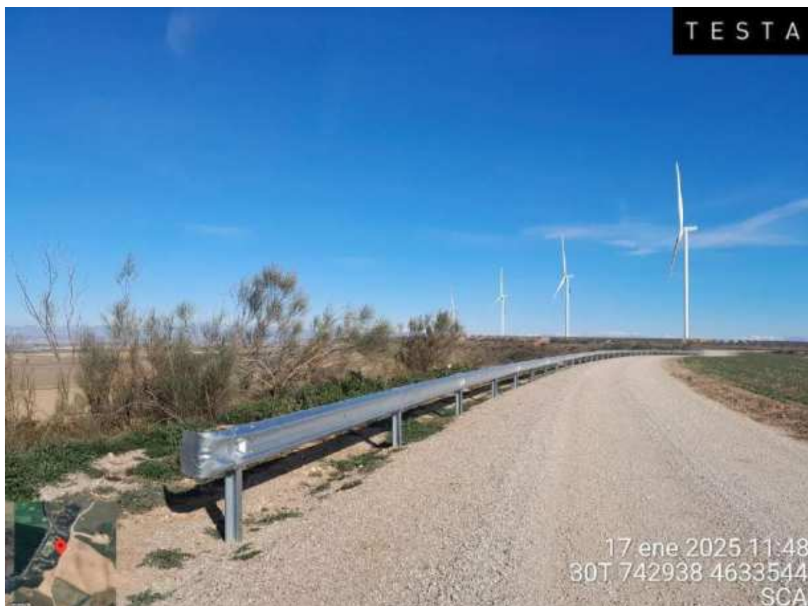
Imagen 2. Colocación de biondas en SCA
