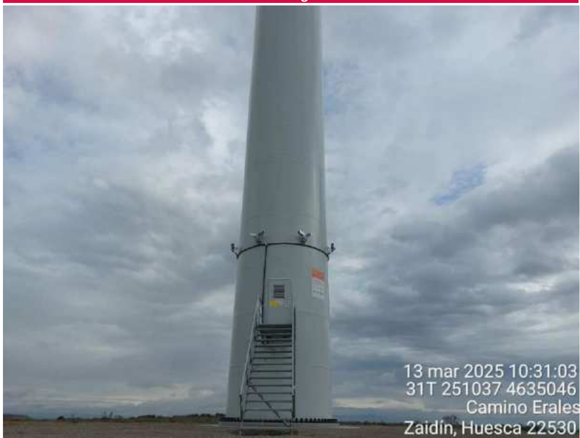
Imagen 1. Cámaras 3D Observer en SC1-01.
