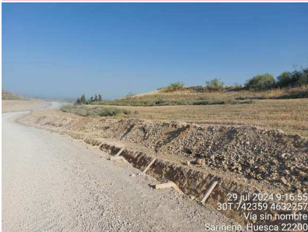
Imagen 1. Trabajos pendientes de hormigonado en cuneta en SCA parados por alerta roja de incendios.
