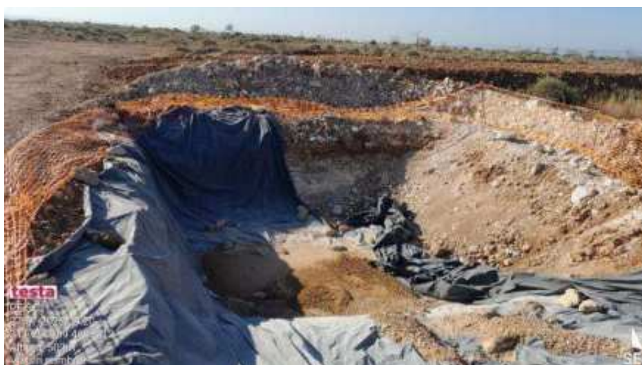
Pozo de lavado en SC1-1
