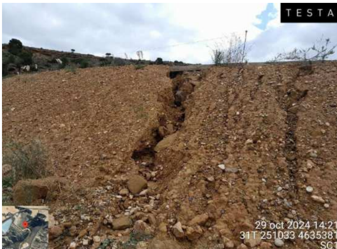
Imagen 2. Cárcava en el talud del vial de acceso a SC1
