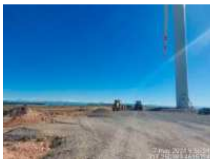
Trabajos de restauración en SCI-01
