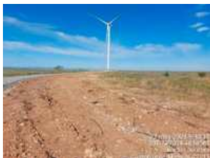
Vial entre SCI-03 y SCI-02 restaurado
