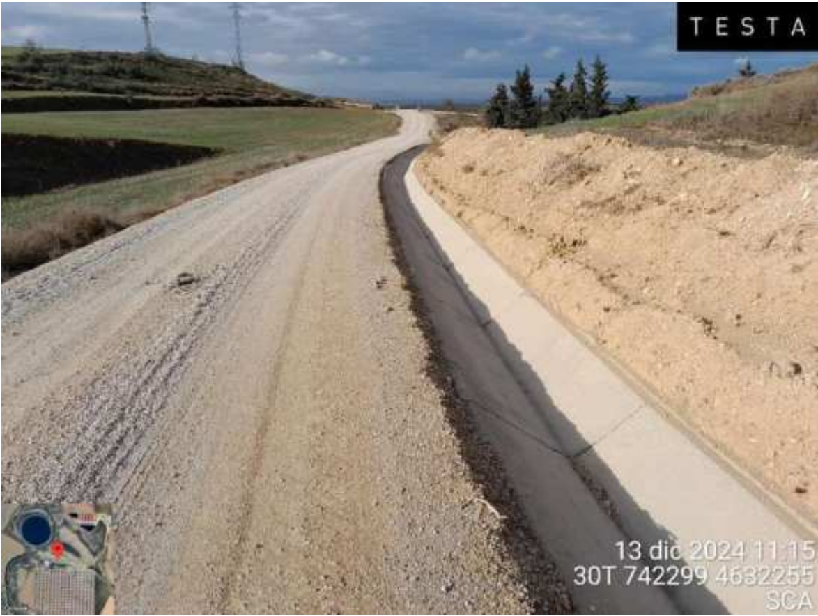
Imagen 1. Cuneta en el vial de entrada
