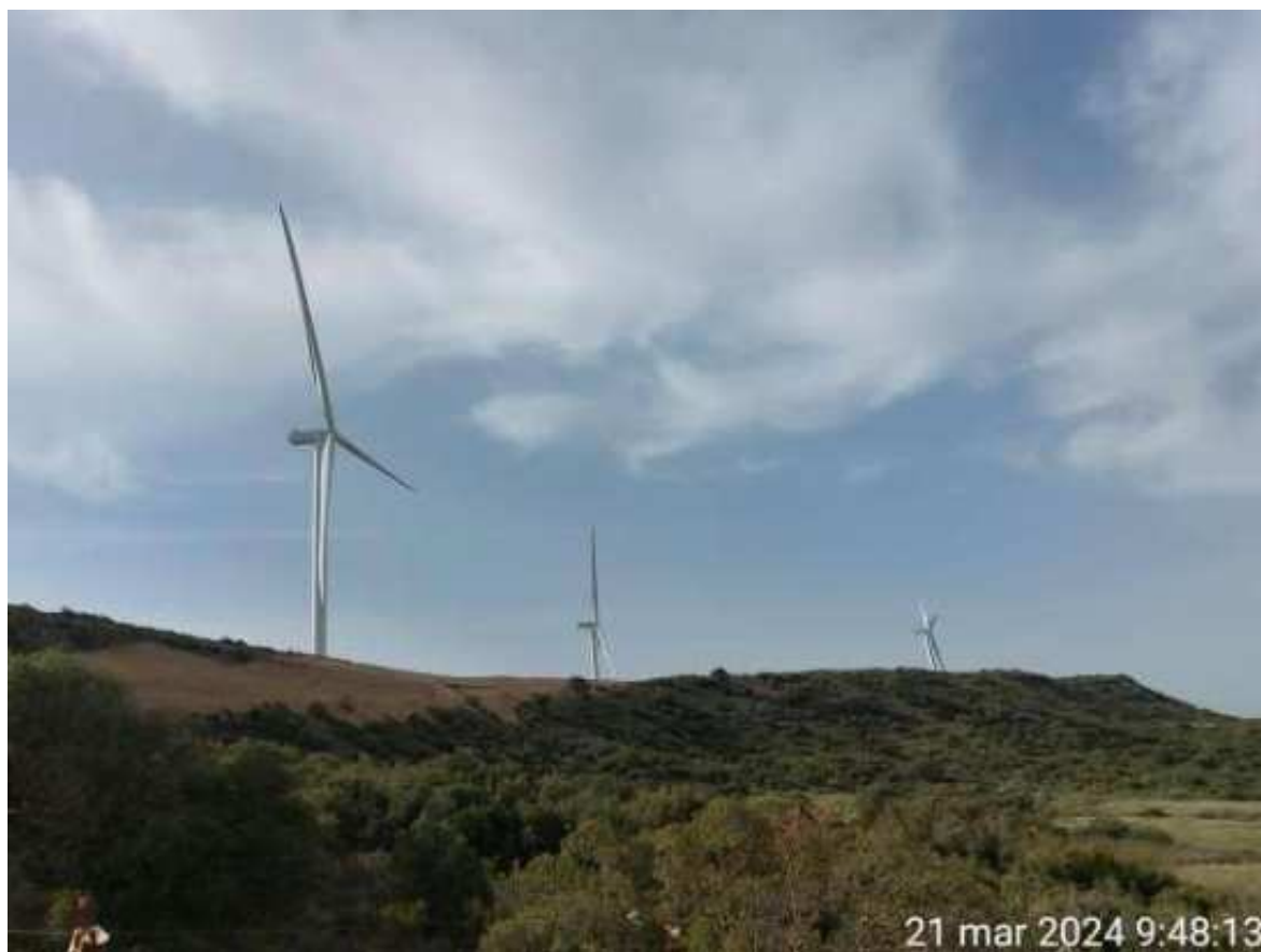
Imagen 2. SC1 con el montaje finalizado.
