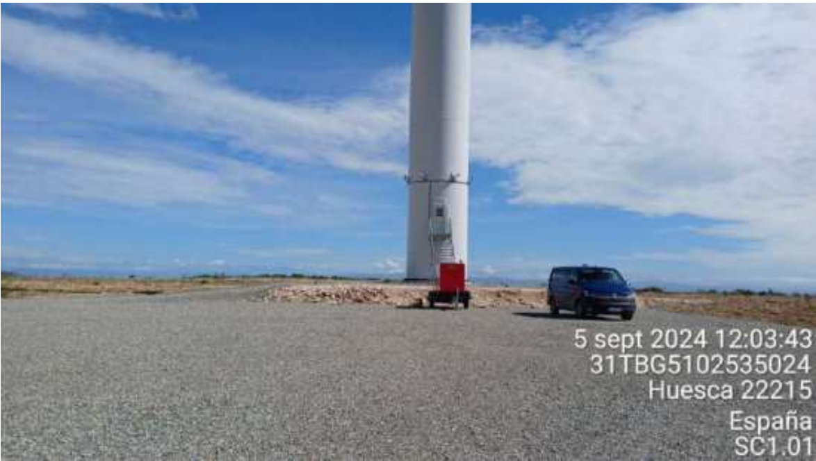
Imagen 1. Trabajos internos en SC1-01.
