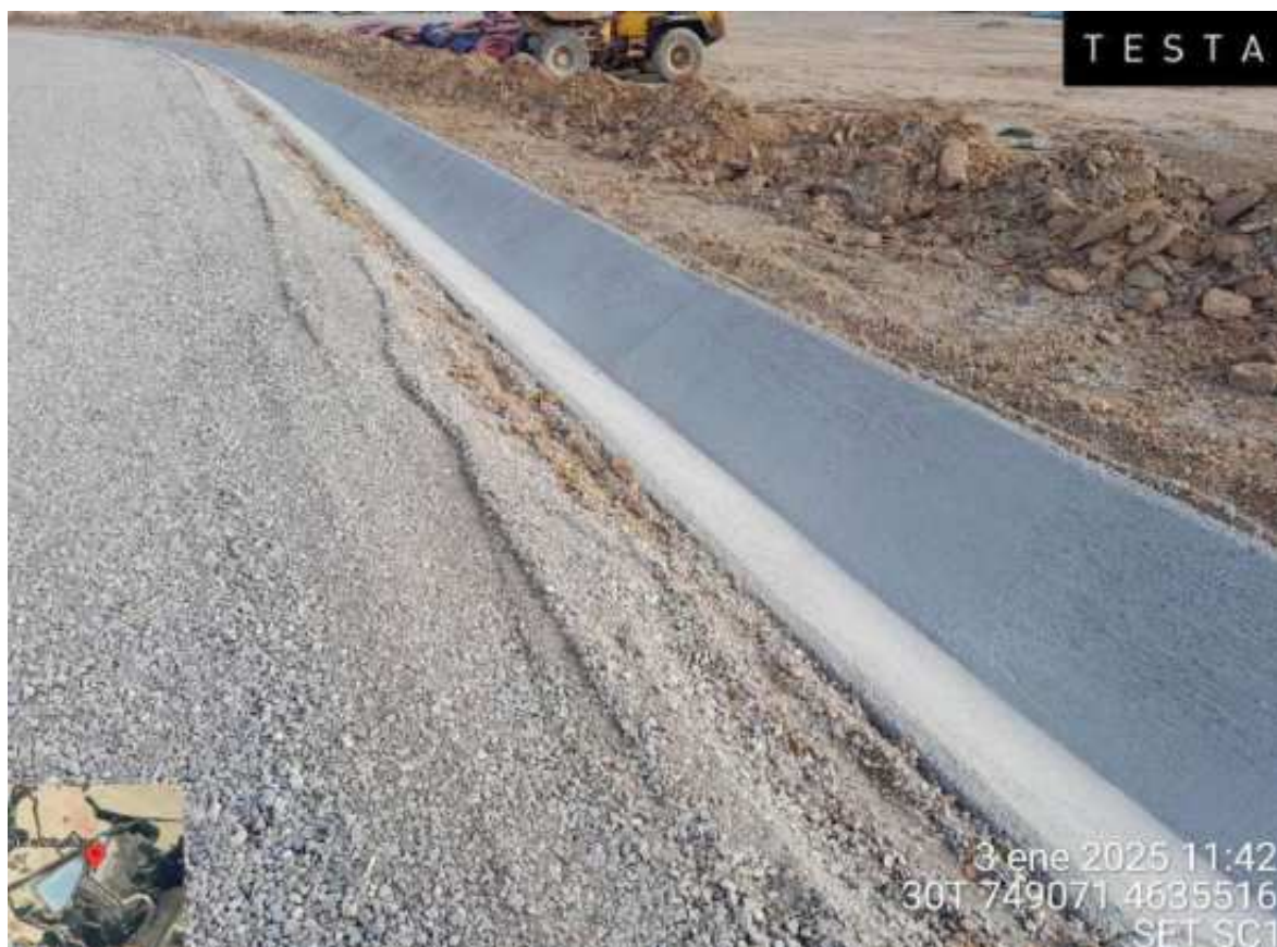
Imagen 2. Cuneta en SET CIN1
