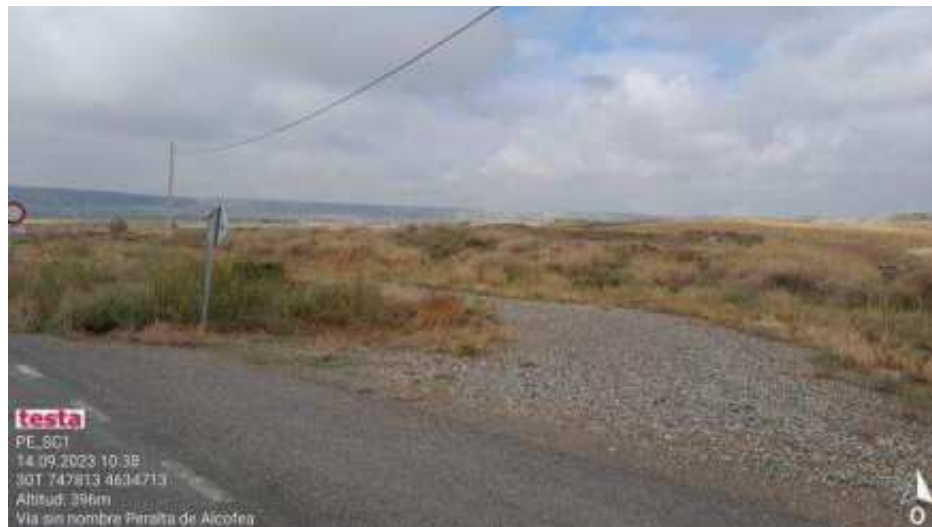
Futuro cruce de línea de evacuación en SC1
