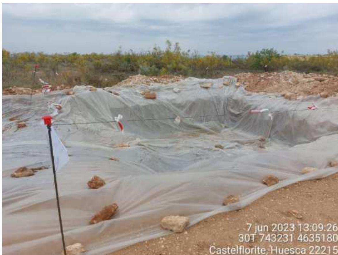
Imagen 3. Pozo de lavado en buenas condiciones.
