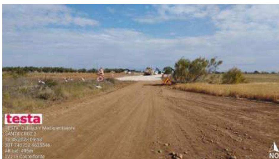
Apertura de viales y plataformas.
