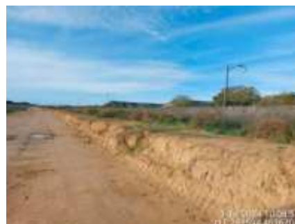
Zanja RMT a hidrosembrar
