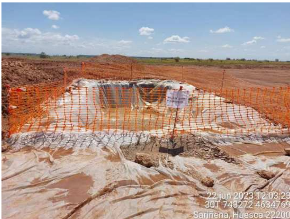
Imagen 1. Pozo de lavado en buenas condiciones
