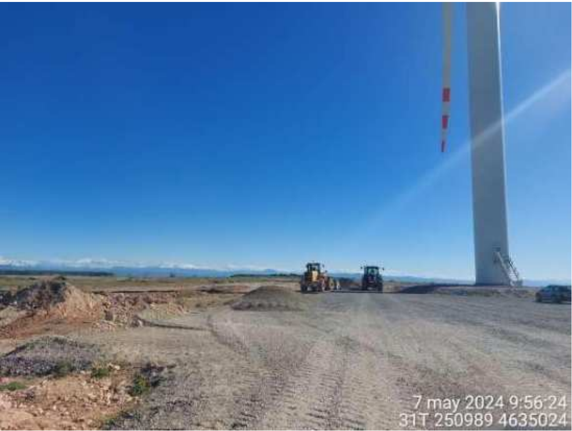
Imagen 1. Comienzo de trabajos de restauración en SC1-01.
