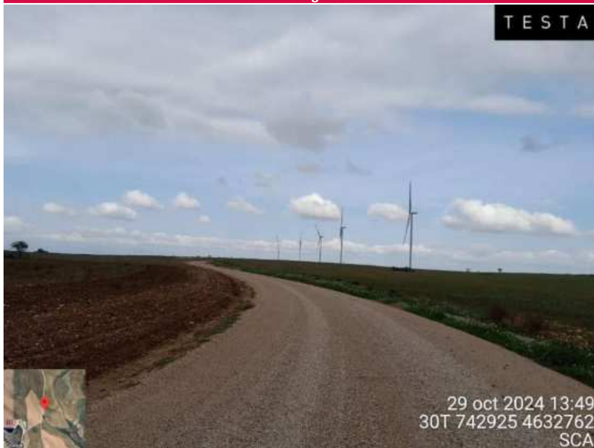
Imagen 1. Imagen panorámica de los 5 aerogeneradores de SCA
