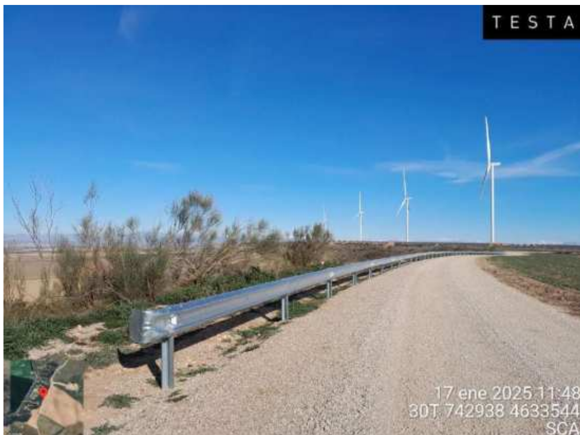
Imagen 2. Colocación de biondas en SCA
