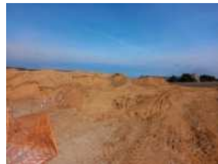
Restaurado pozo lavado y limpieza correcta
