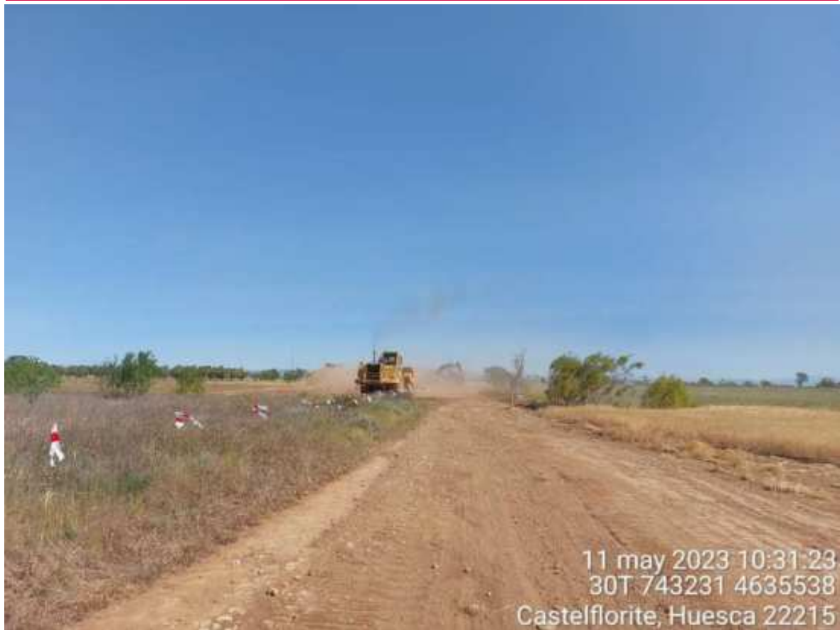
Imagen 3. Maquinaria trabajando en SCII.
