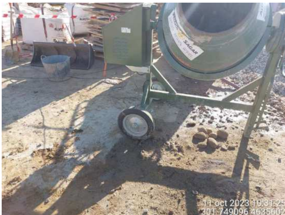
Imagen 2. No conformidad leve. Hormigonera trabajando sin protección del suelo, cayendo restos de cemento sobre él provocando su contaminación.
