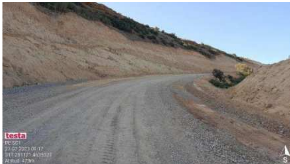
Adecuación del vial de subida a SC1
