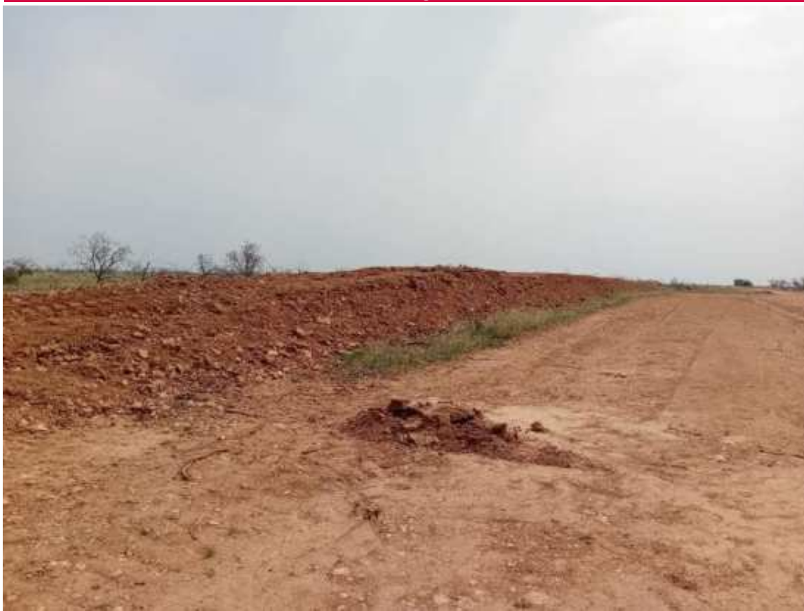
Imagen 3. Separación de la tierra vegetal realizada del modo correcto en SC1.
