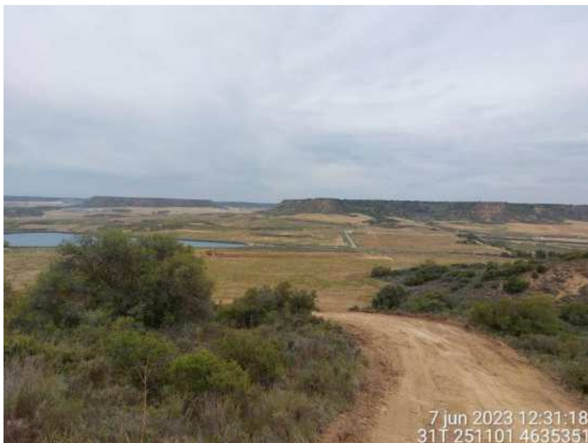
Imagen 2. Desbroce en el vial de SC1 conflictivo.
