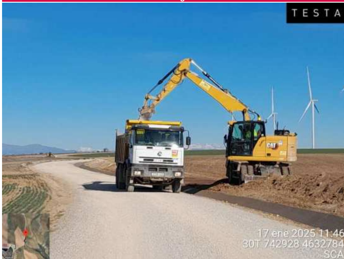
Imagen 1. Movimientos de tierra en SCA
