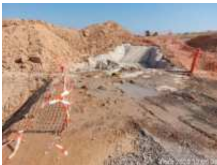
NC colmatación pozo lavado en SET
