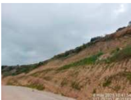
Evolución positiva hidrosiembra talud
