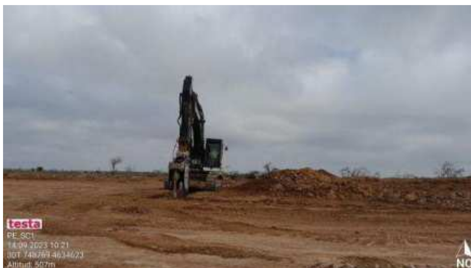
Maquinaria en zanja de evacuación en SC1
