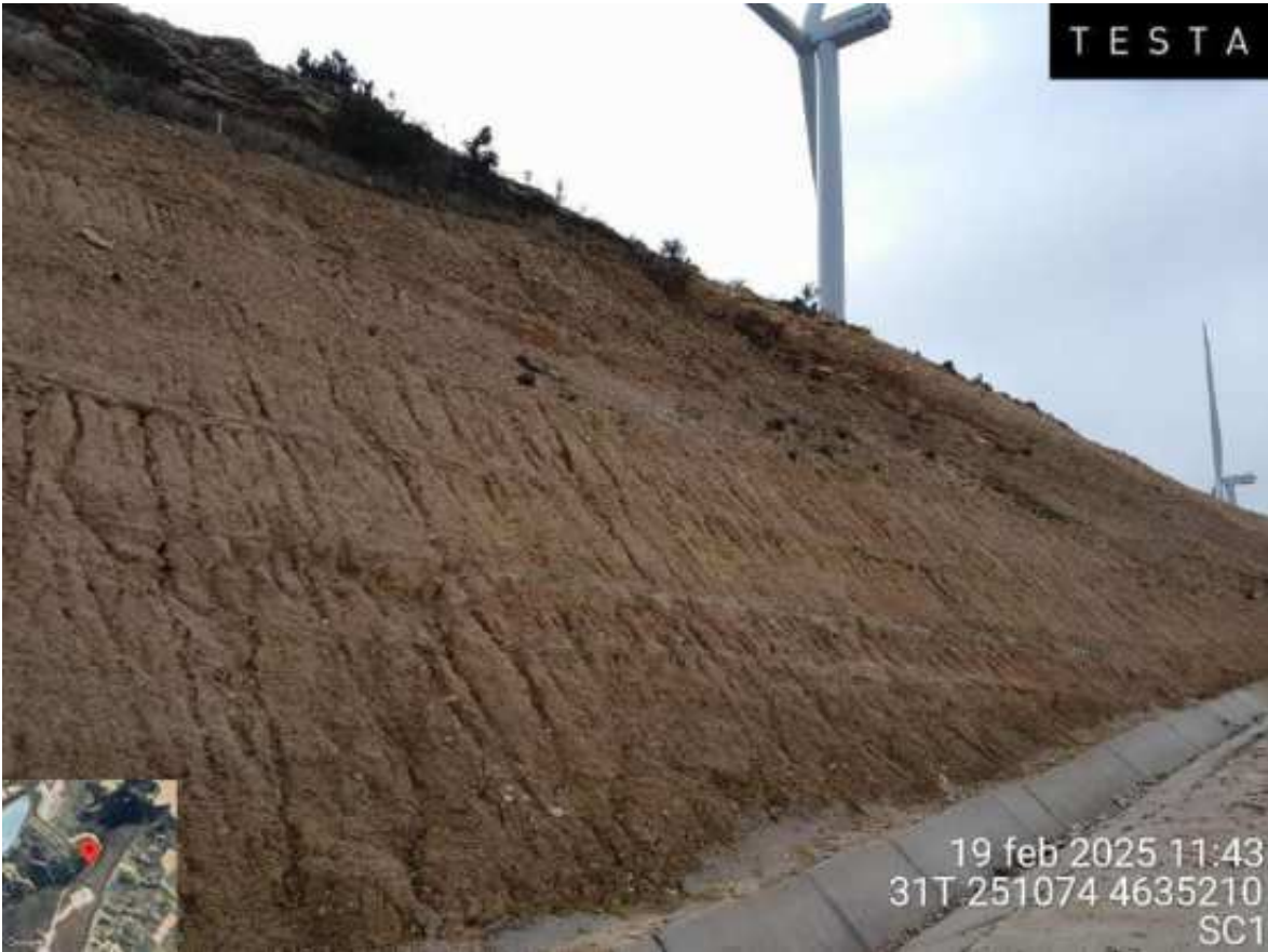
Imagen 1. Talud hidrosechado en SC1
