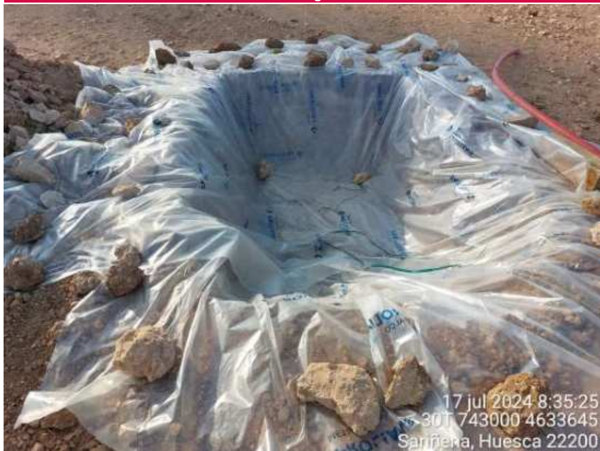
Imagen 1. Pozo de lavado creado en SCA para los lavados de las cubas en el hormigonado de las cubetas.
