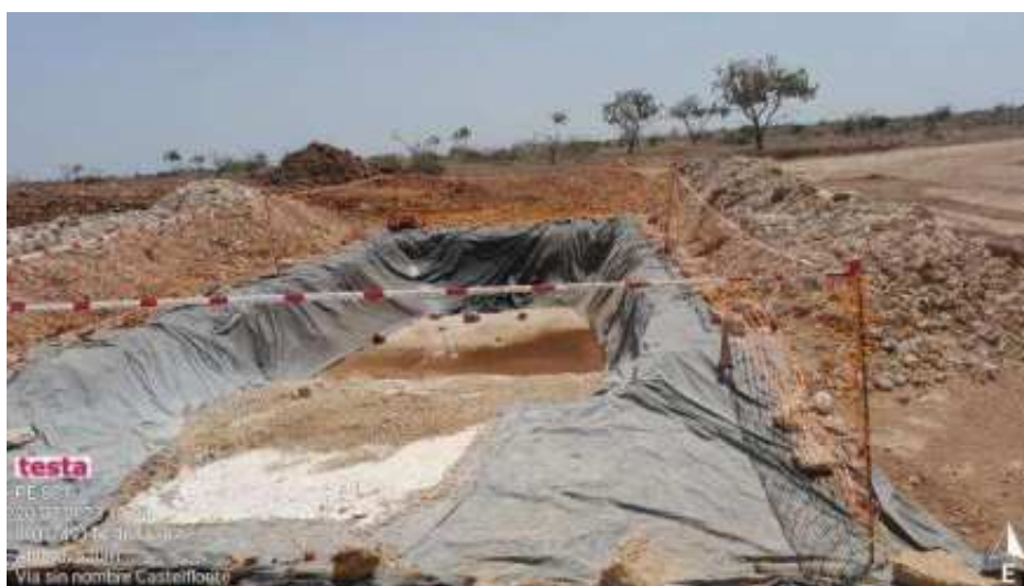
Adecuación de pozos de lavado en SC1
