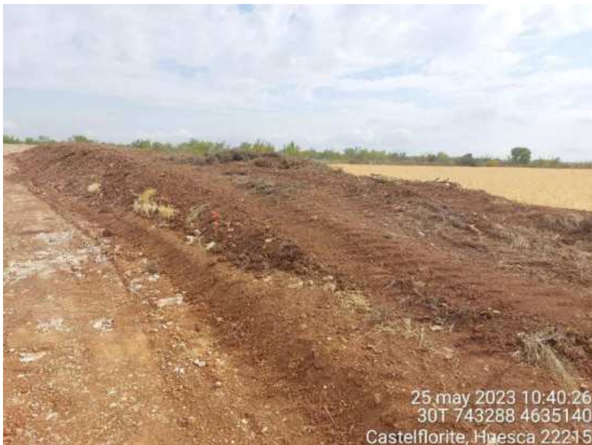
Imagen 3. Cordón de tierra vegetal acopiado correctamente.
