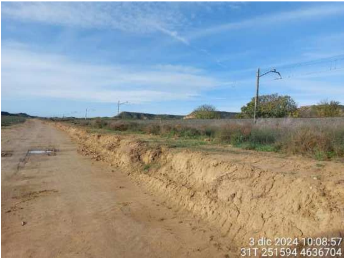
Imagen 1. Zona de zanja RMT a hidrosembrar cercana a SET SC1.
