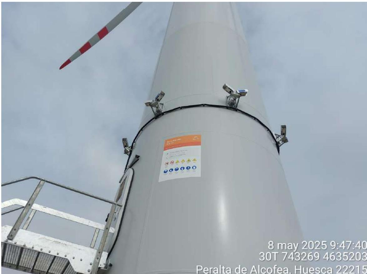
Imagen 2. Cámaras del sistema 3D Observer de SC2-02.
