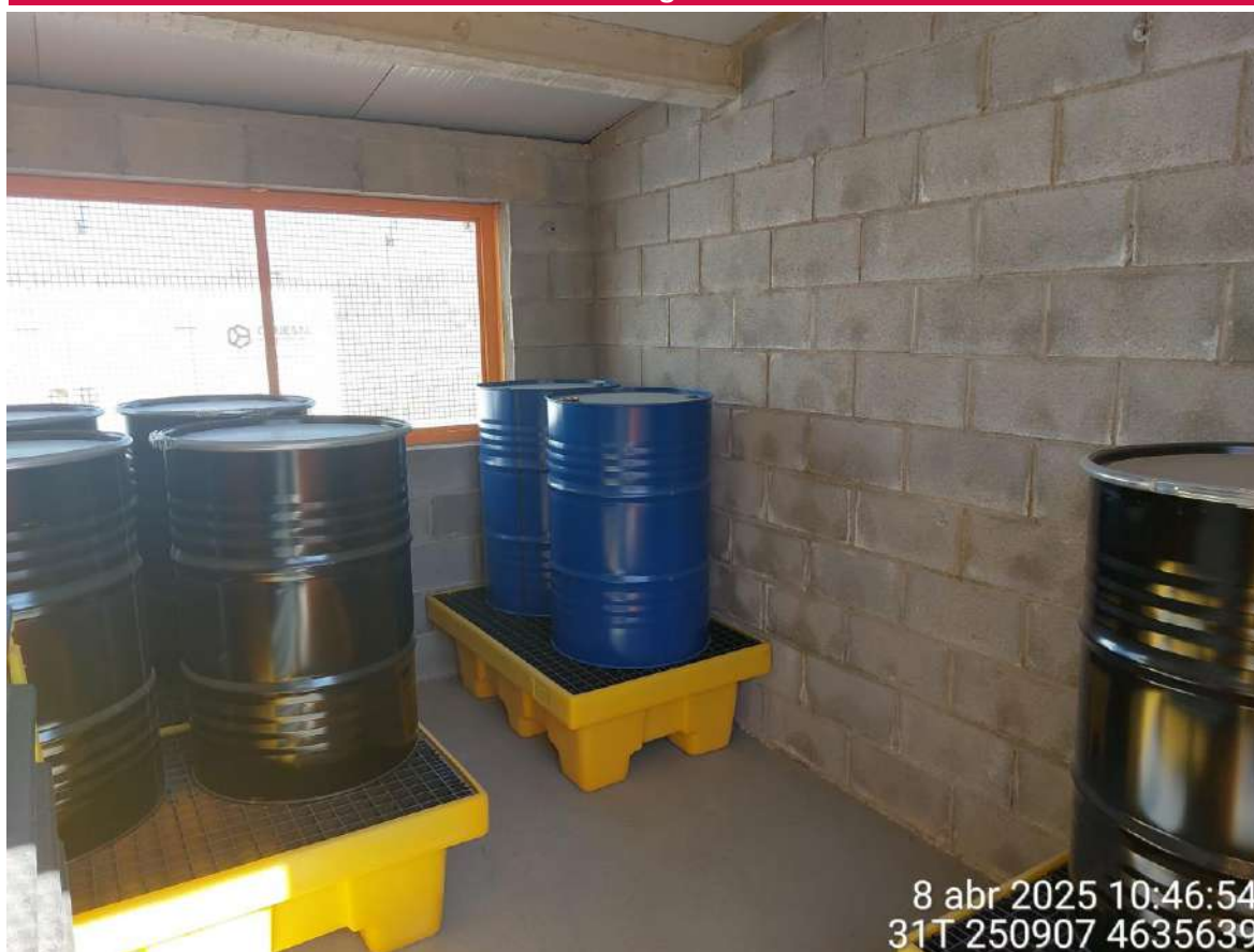
Imagen 1. Punto limpio SET SC1. Almacén residuo peligroso.
