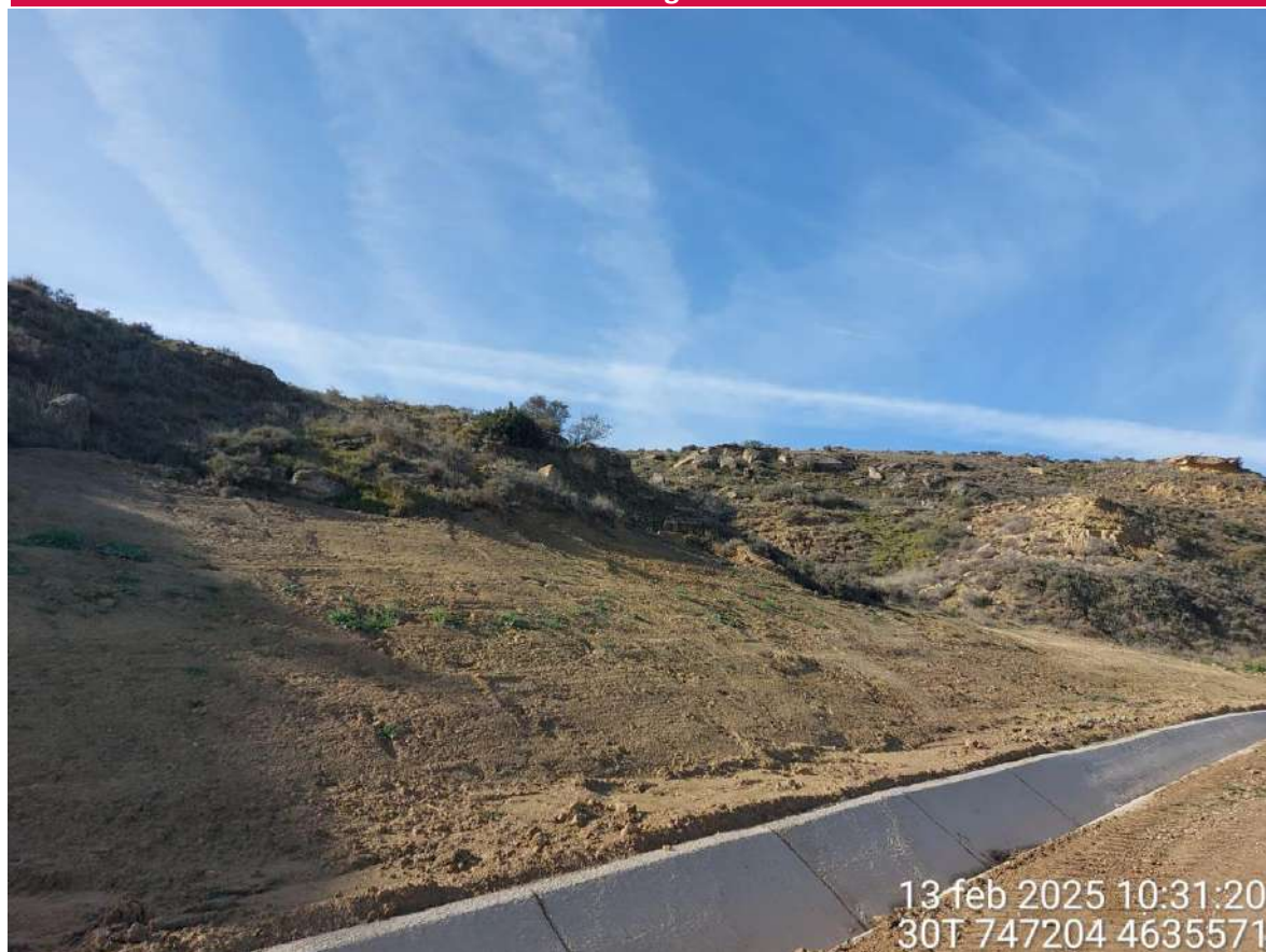
Imagen 1. Talud en SCA hidrosechado.
