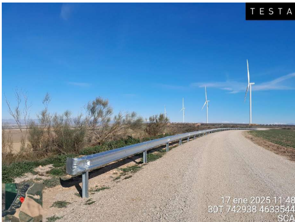
Imagen 2. Colocación de biondas en SCA
