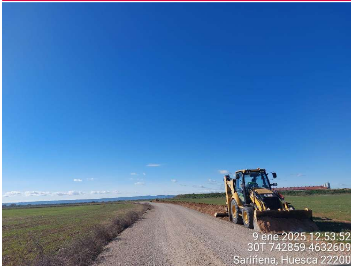
Imagen 1. Maquinaria realizando excavaciones para realización de cunetas en SCA.
