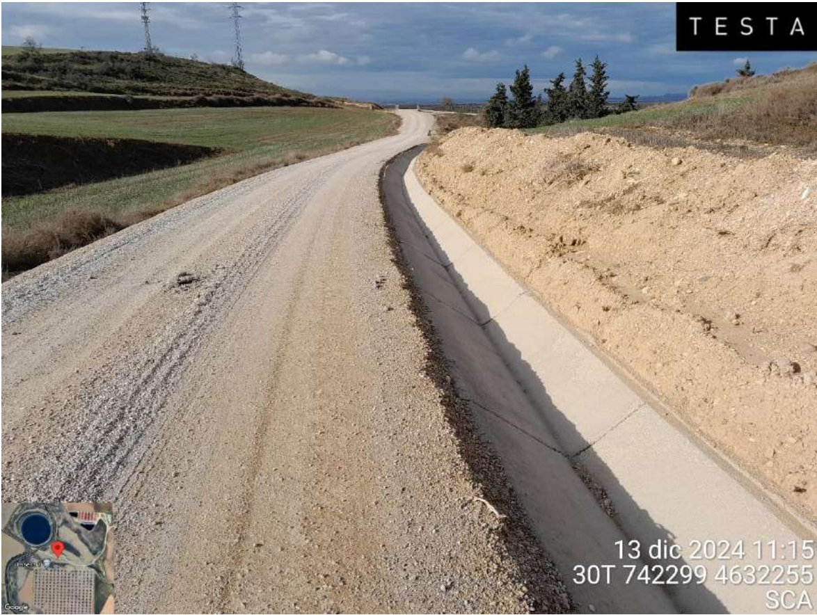
Imagen 1. Cuneta en el vial de entrada
