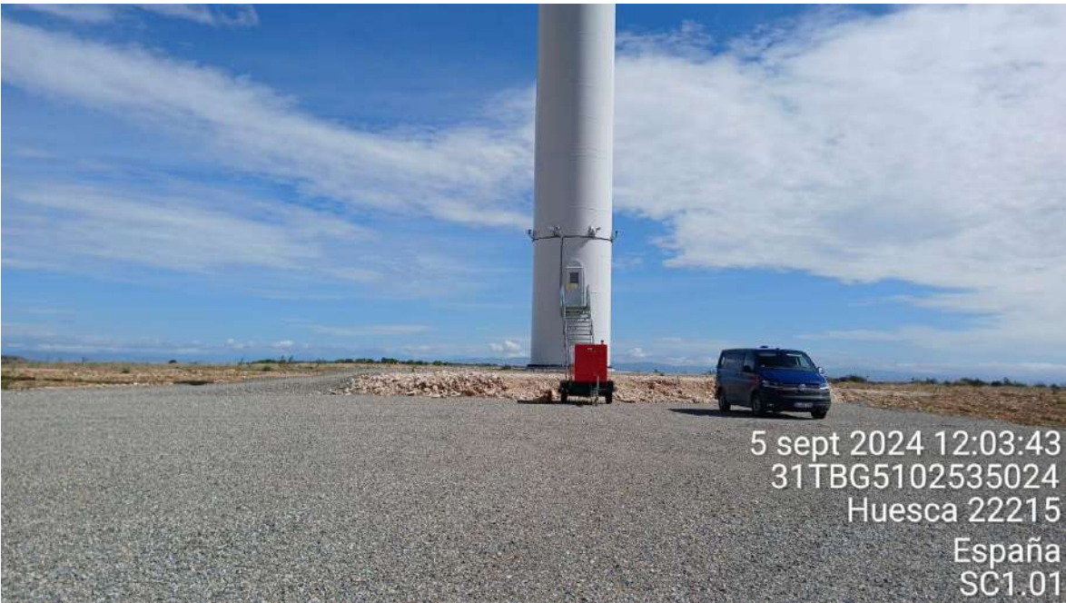
Imagen 1. Trabajos internos en SC1-01.
