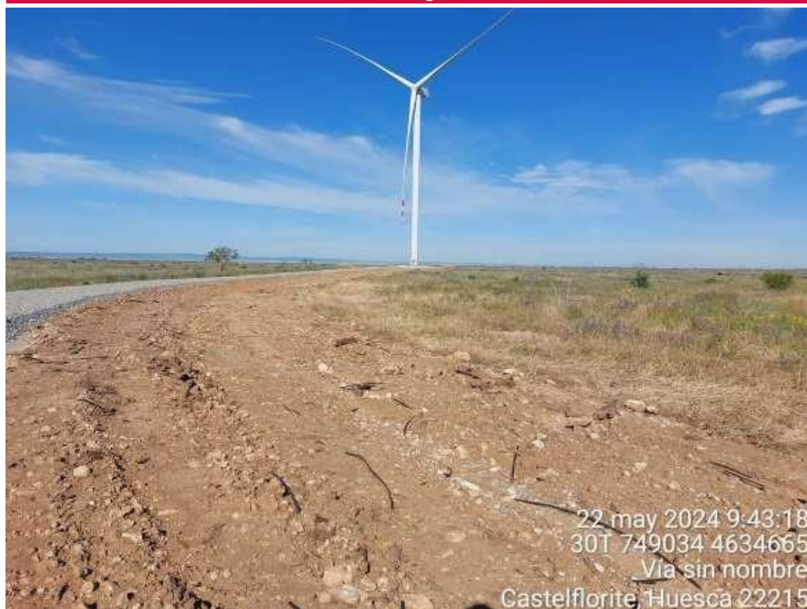
Imagen 1. Vial entre SC1-03 y SC1-02 restaurado.
