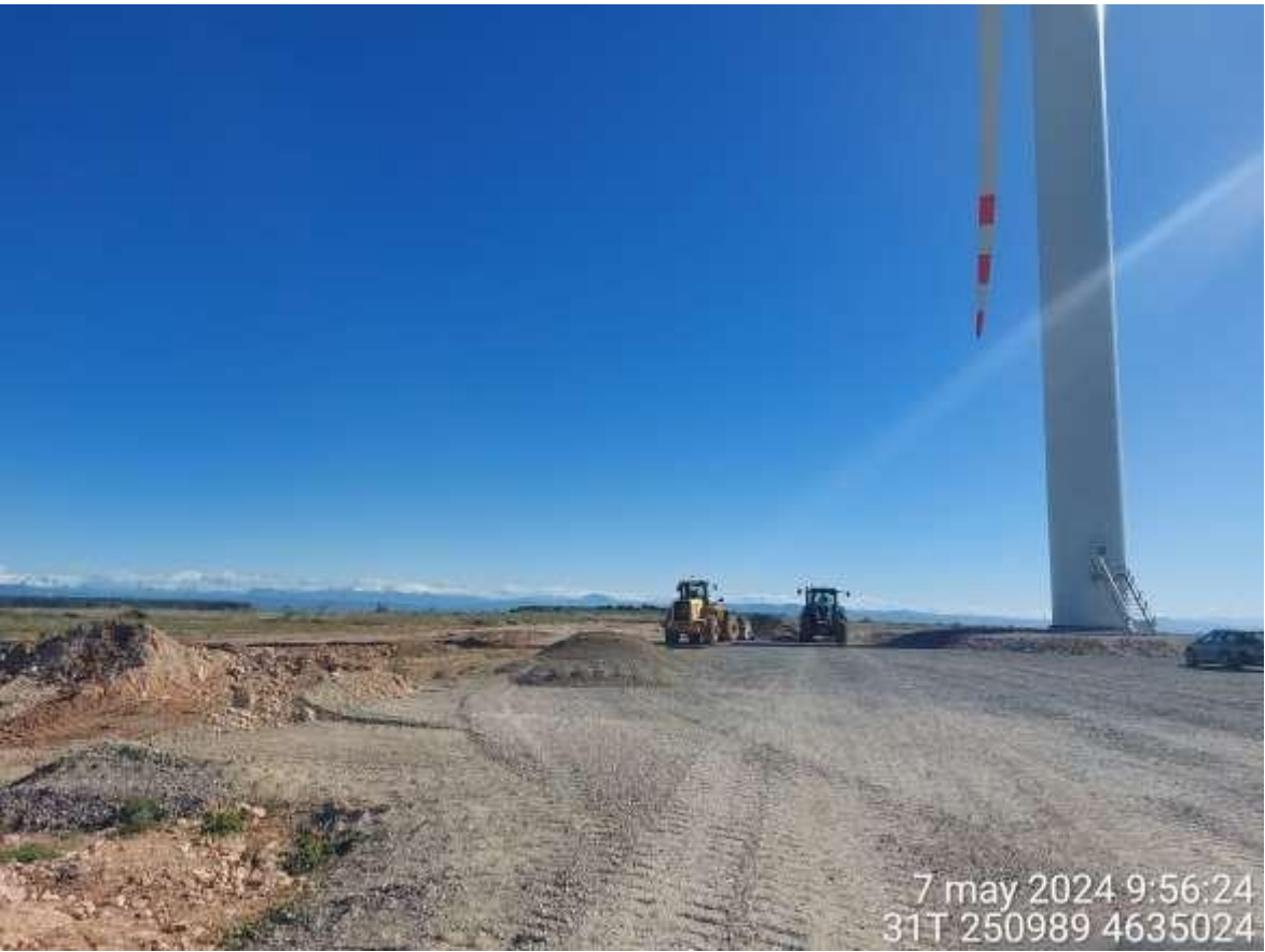
Imagen 1. Comienzo de trabajos de restauración en SC1-01.
