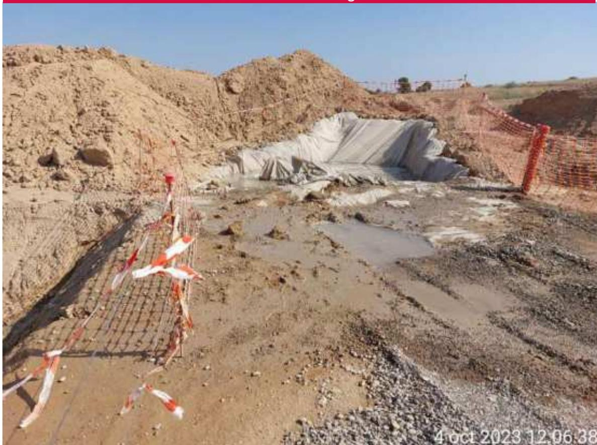
Imagen 1. No conformidad leve. Colmatación del pozo de lavado en SET.
