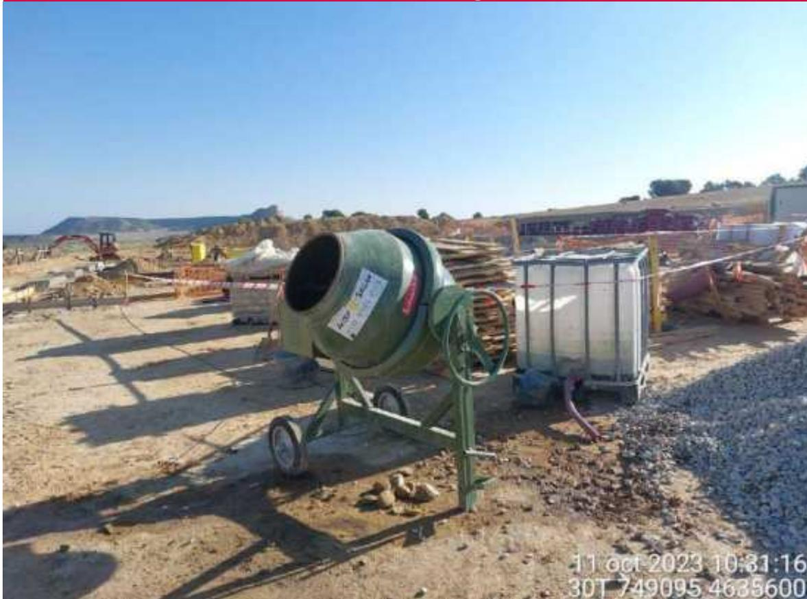
Imagen 1. No conformidad leve. Hormigonera trabajando sin protección del suelo, cayendo restos de cemento sobre él provocando su contaminación.
