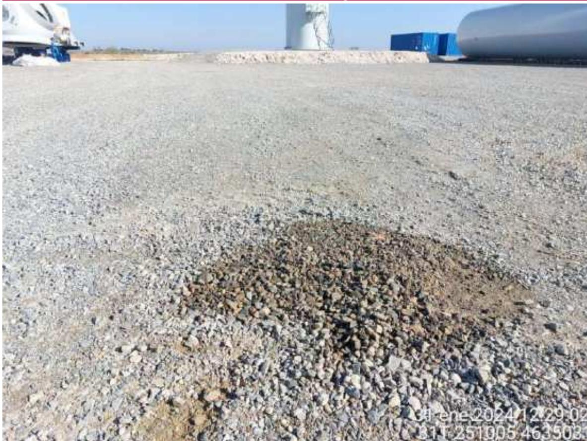
Imagen 1. No conformidad leve. Manchas por fugas de maquinaria en SC1.
