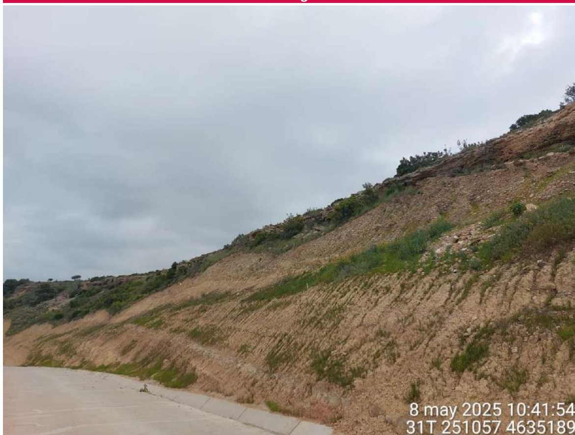
Imagen 1. Evolución positiva de la hidrosiembra en talud de subida a SC1.
