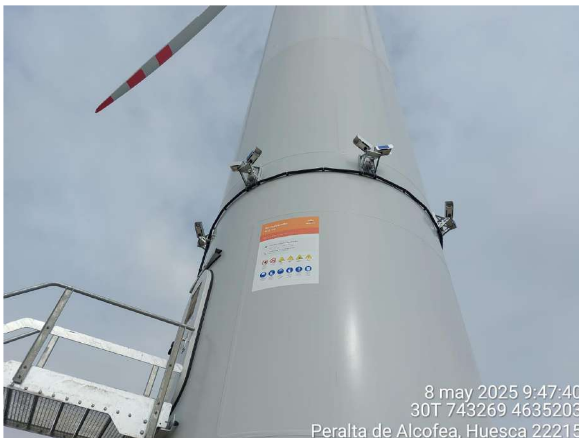
Imagen 2. Cámaras del sistema 3D Observer de SC2-02.
