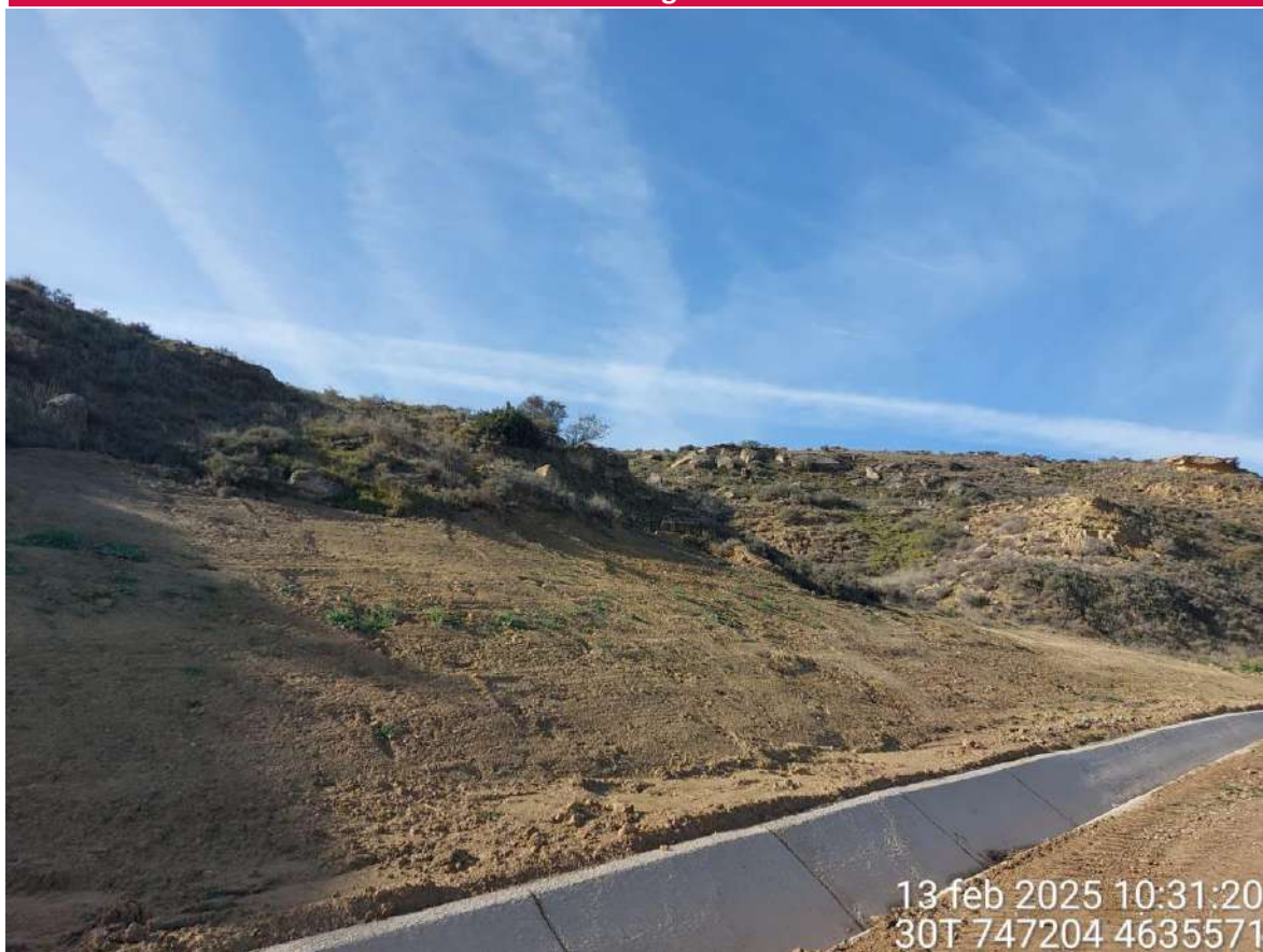
Imagen 1. Talud en SCA hidrosechado.
