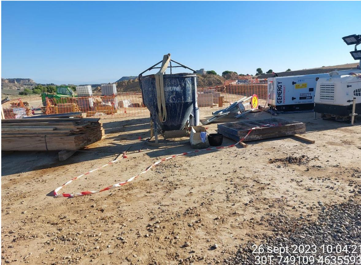
Imagen 1. Zona de la SET con hormigonera sin protección que solucionan cuando se notifica.
