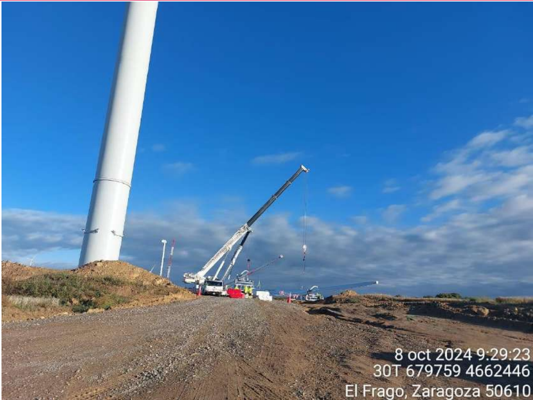
Imagen 1. Transporte de palas de PAU-02 a PAU-08 para el montaje de esa máquina.
