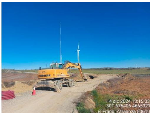
Maquinaria en la odt para permitir paso del agua en barranco entre San Roque y torre medición
