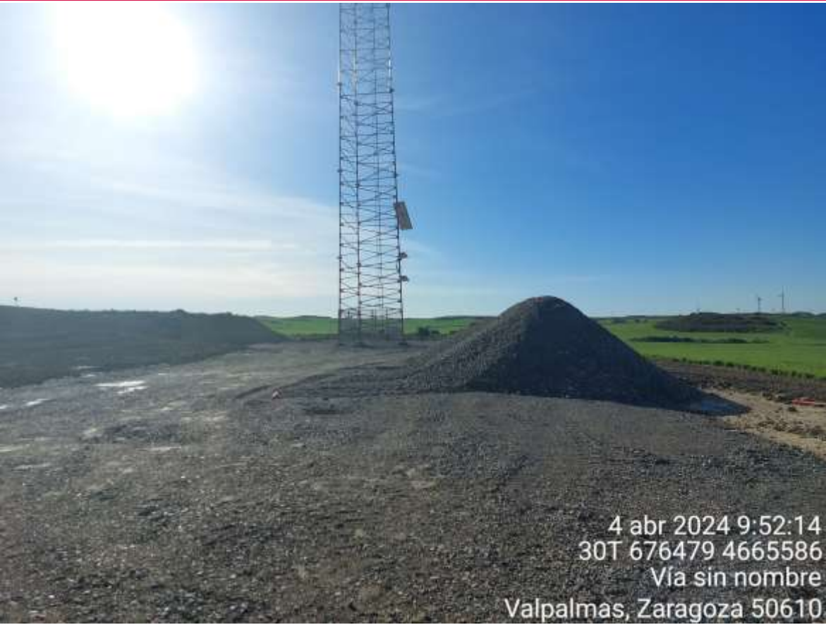
Imagen 1. TM restaurada con zahorra acopiada para extendido.
