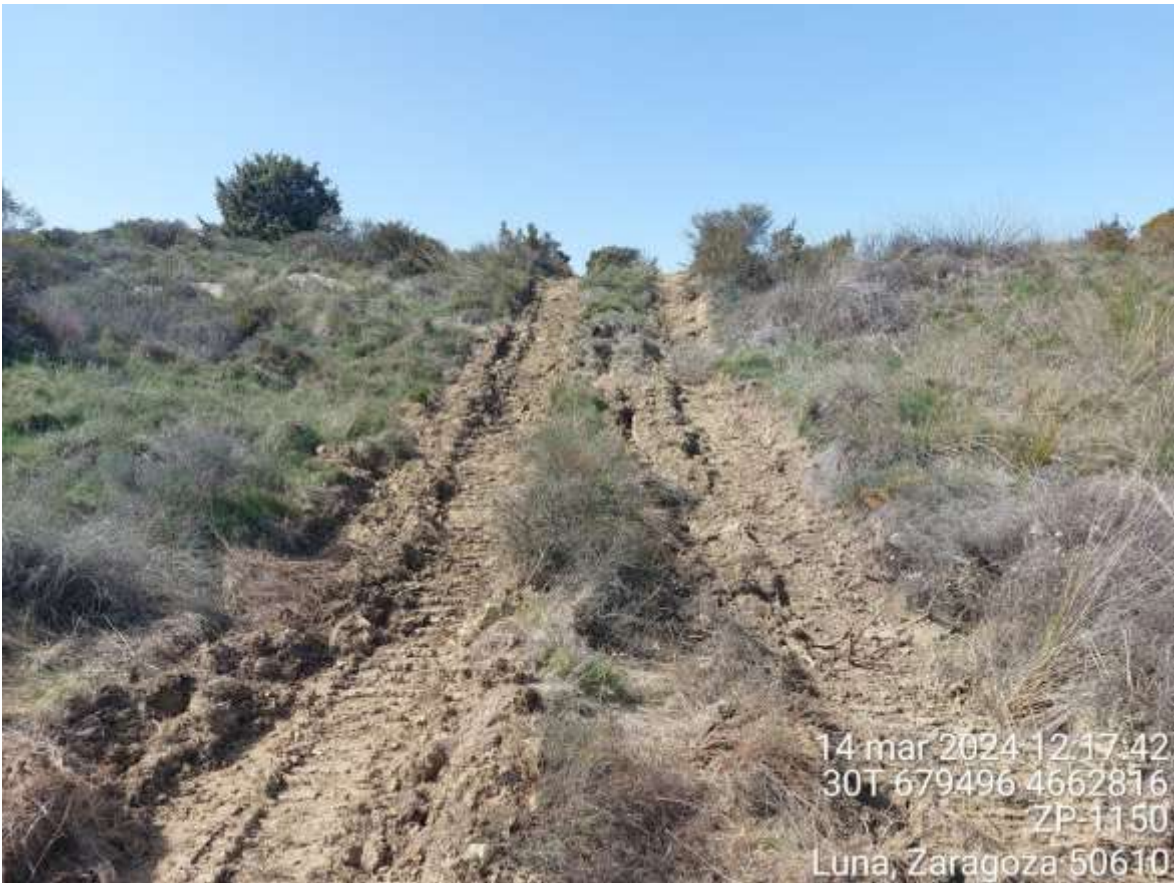
Imagen 1. NC grave. Sobre afección en zona de vegetación natural por paso de maquinaria de cadenas.
