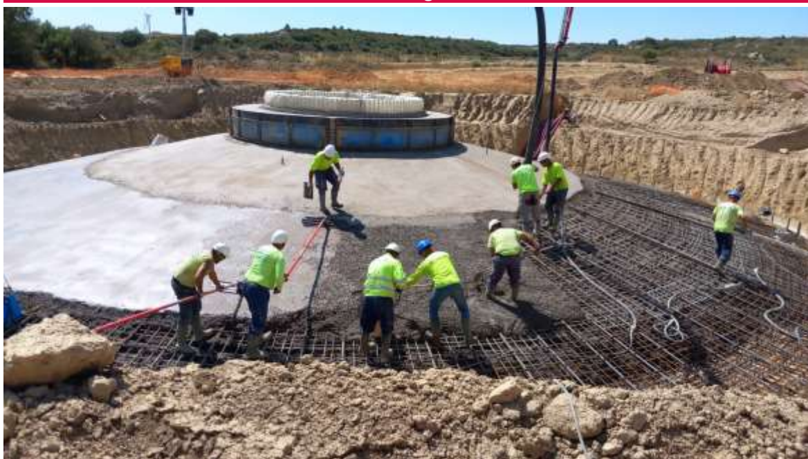
Imagen 1. Hormigonado de la posición PAU-02.
