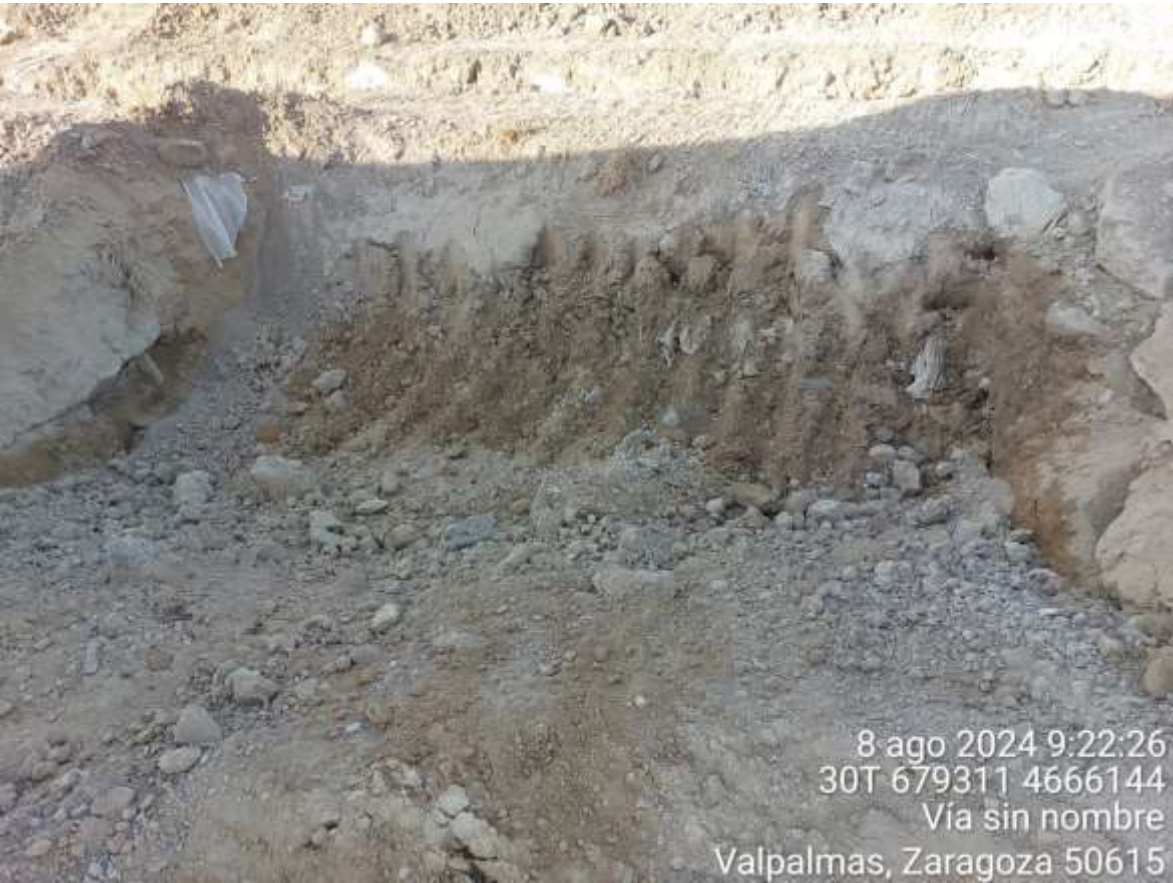
Imagen 1. Pozo de lavado durante su restauración a falta de quitar totalmente el plástico protector.
