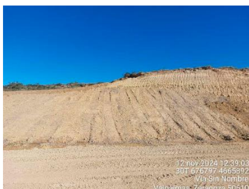
Talud SR-01 tras restauración morfológica, a falta de tierra vegetal
