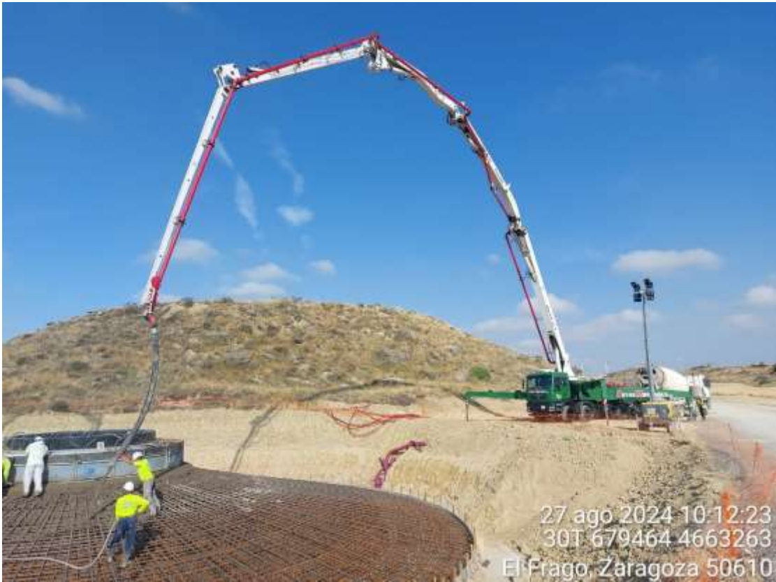
Imagen 1. Bomba trabajando en el hormigonado de PAU-08.
