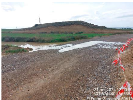
Barranco cegado en vial previo a la obra para permitir el paso del agua
