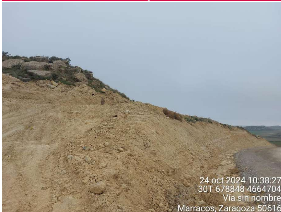
Imagen 1. Talud en PAU-05 que debe restaurarse morfológicamente y realizar una posterior restauración.
