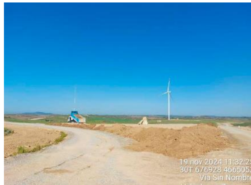
Isleta SR-02 con tierra vegetal para su extendido previo a plantación
