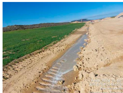
Contaminación suelo pozo lavado Hormigonado SR-02
