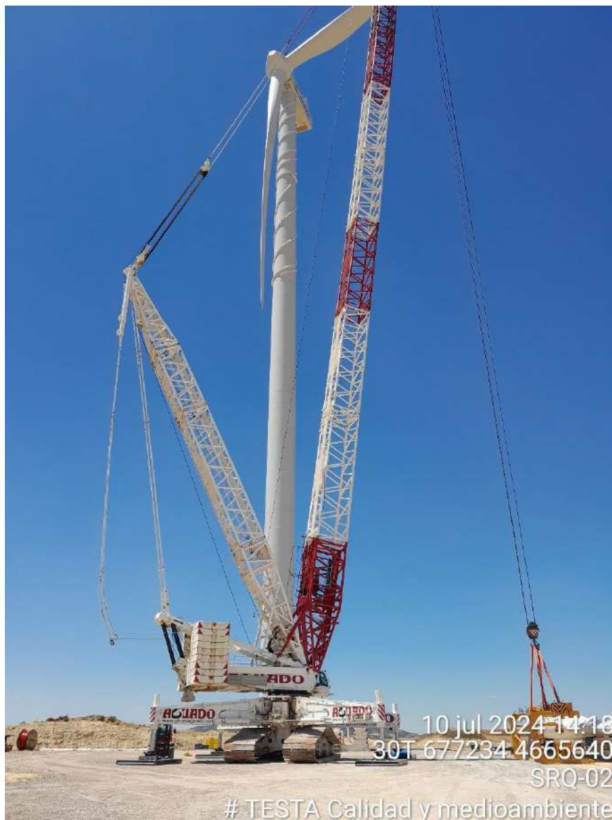
Imagen 1. Levantamiento de palas en la posición SRQ-02
