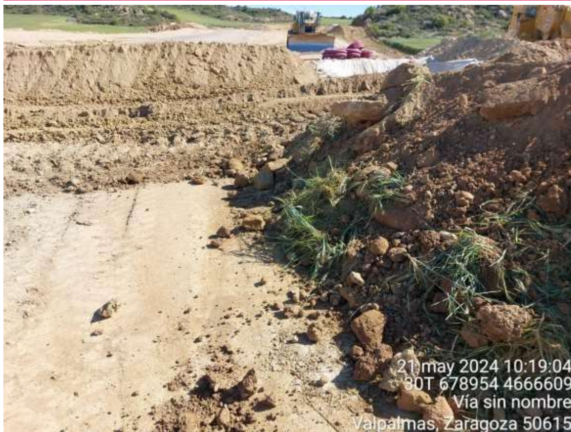
Imagen 1. NC leve. Apertura de zanja sobre residuo de hormigón.
