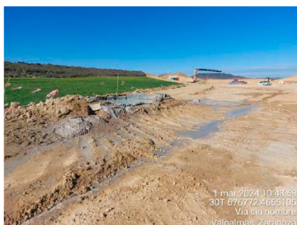
NC 007 contaminación suelo pozo lavado Hormigonado SR-02
