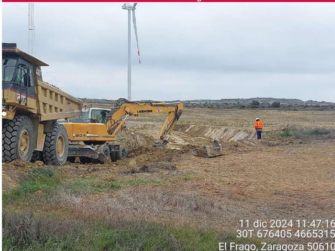
Imagen 1. Continúan los trabajos de excavación para la realización de la odt en el barranco entre SRQ-02 y la TM.
