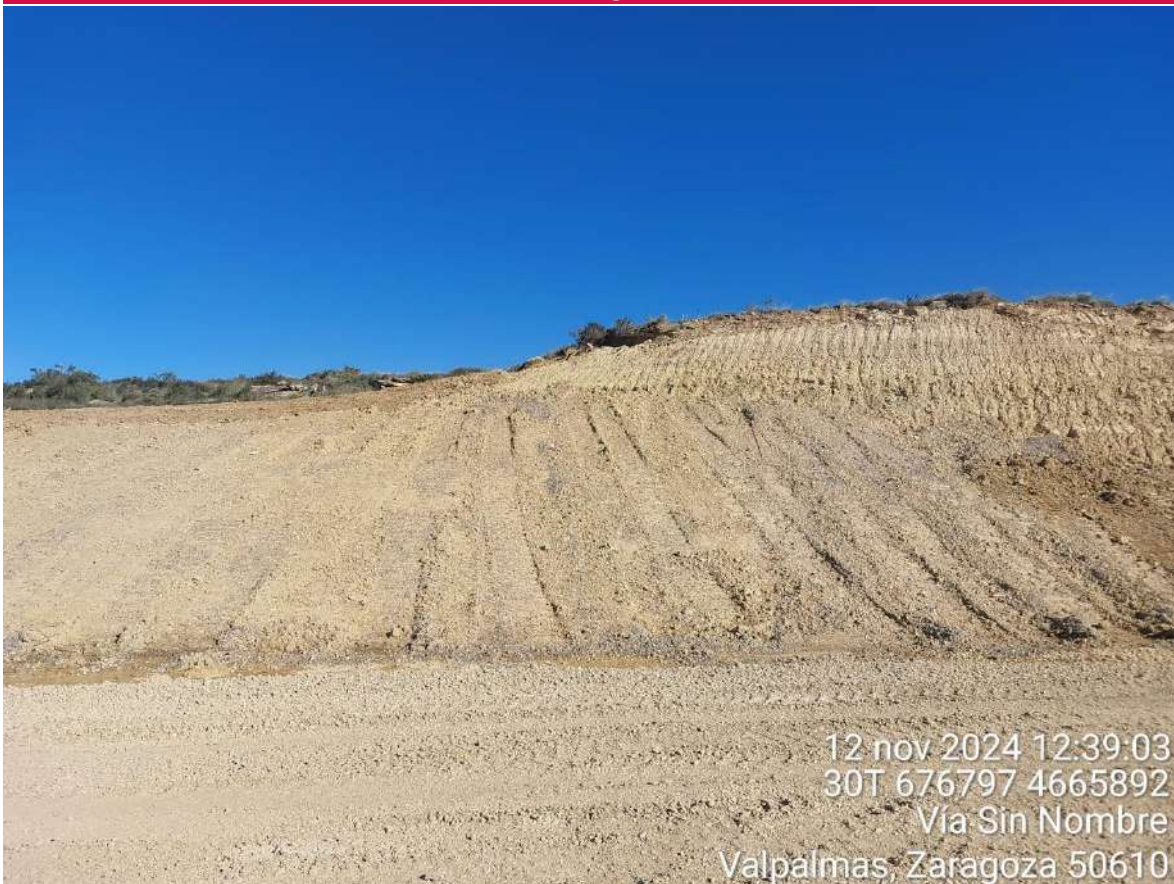
Imagen 1. Talud en SRQ-01 tras la restauración morfológica a falta de la tierra vegetal.
