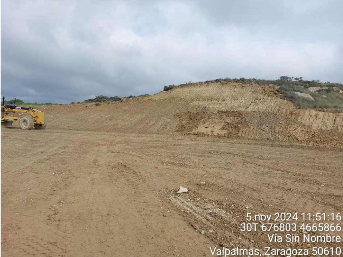
Imagen 1. Maquinaria realizando trabajos de restauración en SRQ-01.
