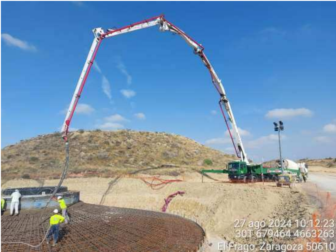
Imagen 1. Bomba trabajando en el hormigonado de PAU-08.
