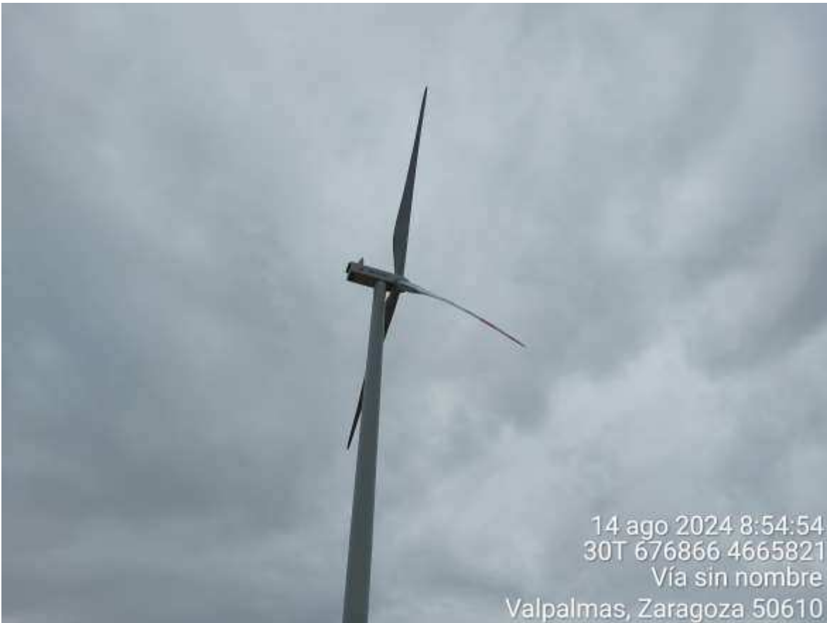
Imagen 1. Aerogenerador número 1 del PE San Roque montado.
