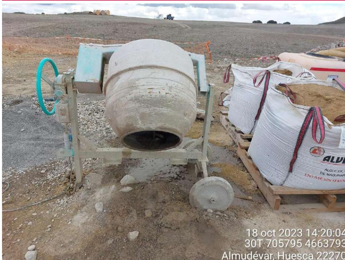
Imagen 1. No conformidad leve. Hormigonera sin protección del suelo con su consiguiente contaminación.
