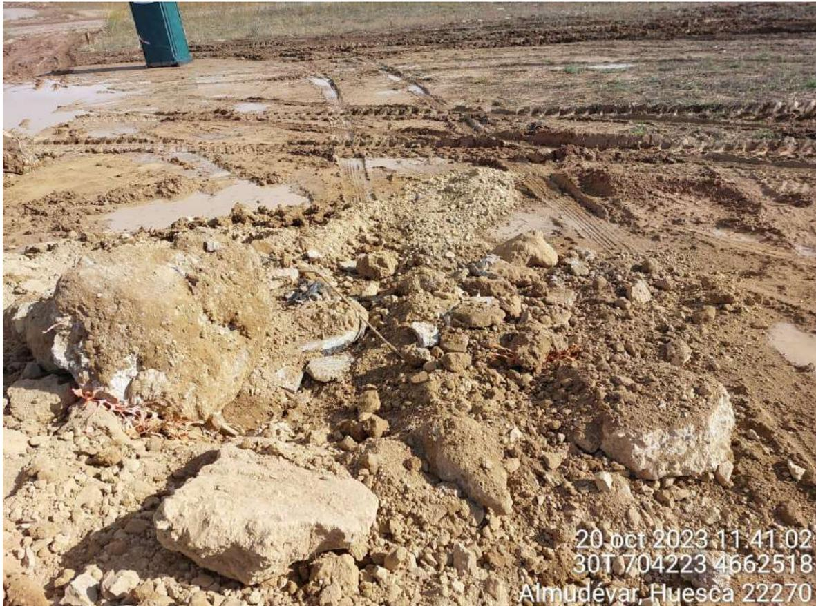
Imagen 1. No conformidad muy grave. Grout y hormigón enterrado bajo el pozo de lavado restaurado.
