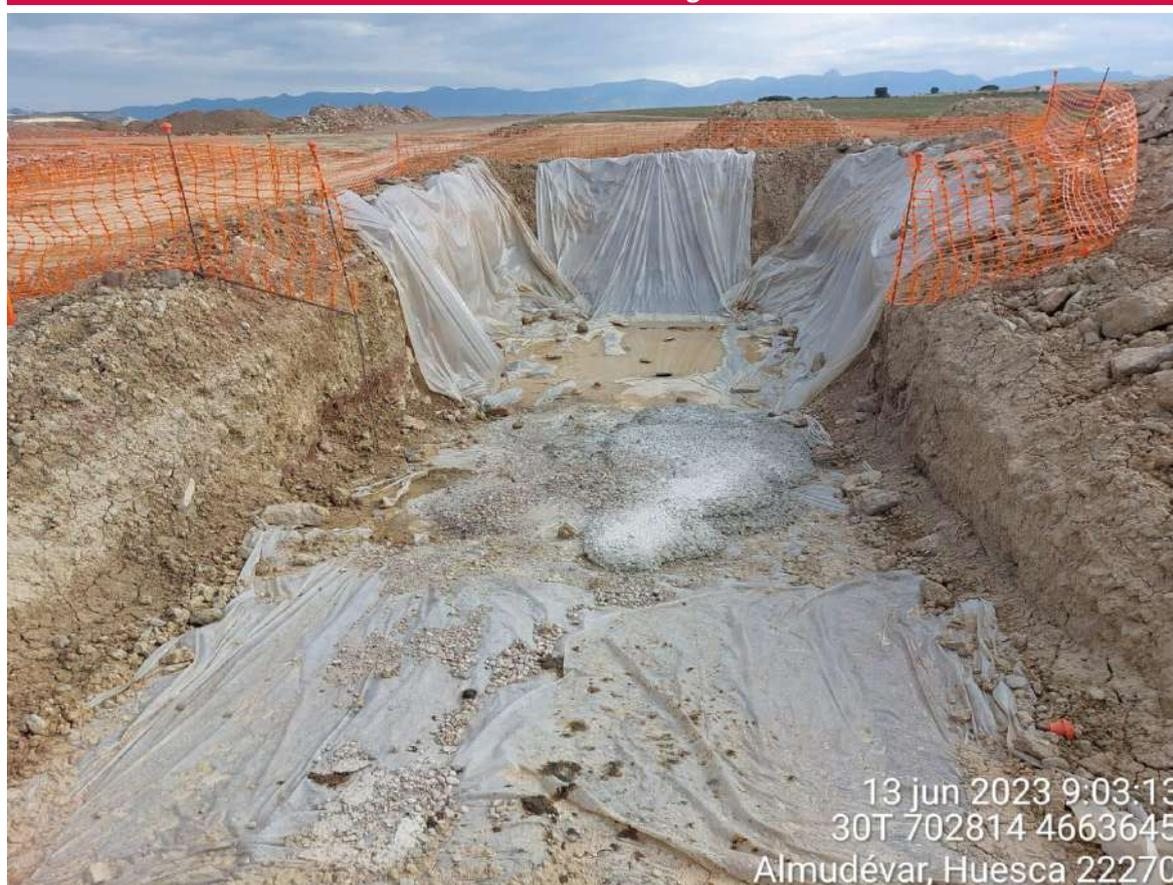
Imagen 1. Pozo de lavado de SIS-01 que debe recubrirse con plástico completamente.
