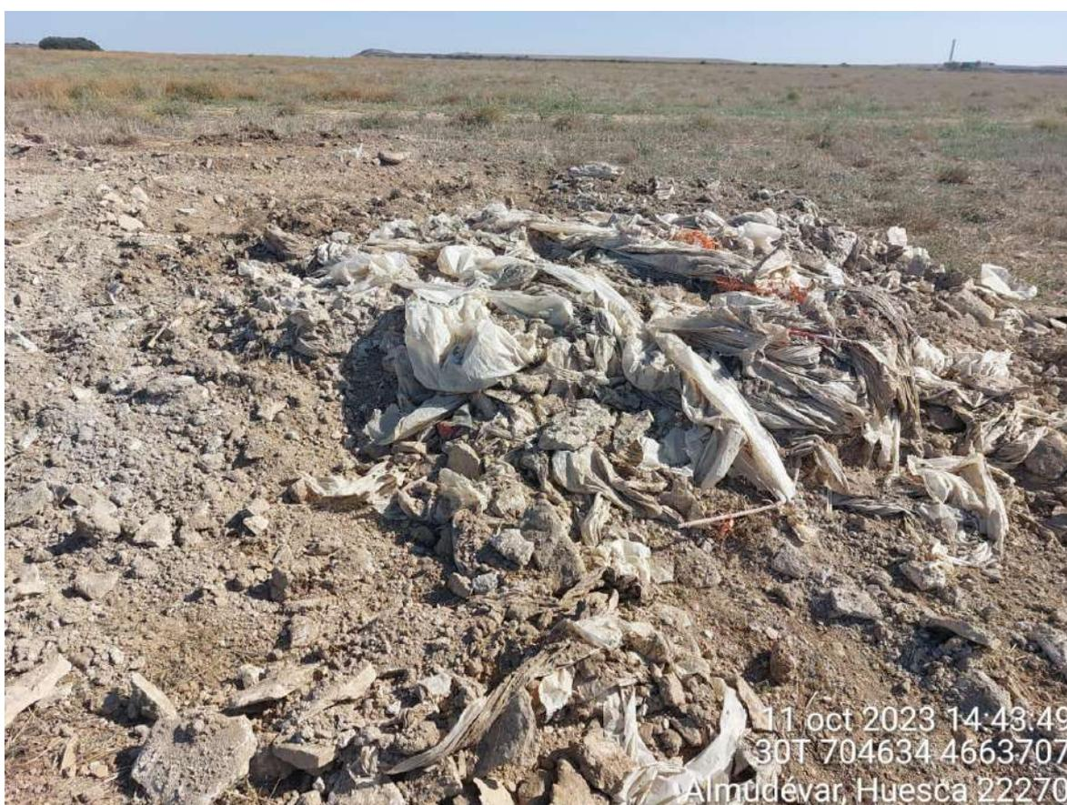
Imagen 1. No conformidad leve. Pozo de lavado de SIS-05 mal restaurado con plásticos, hormigón y balizas mezcladas con la tierra que ha tapado el agujero.
