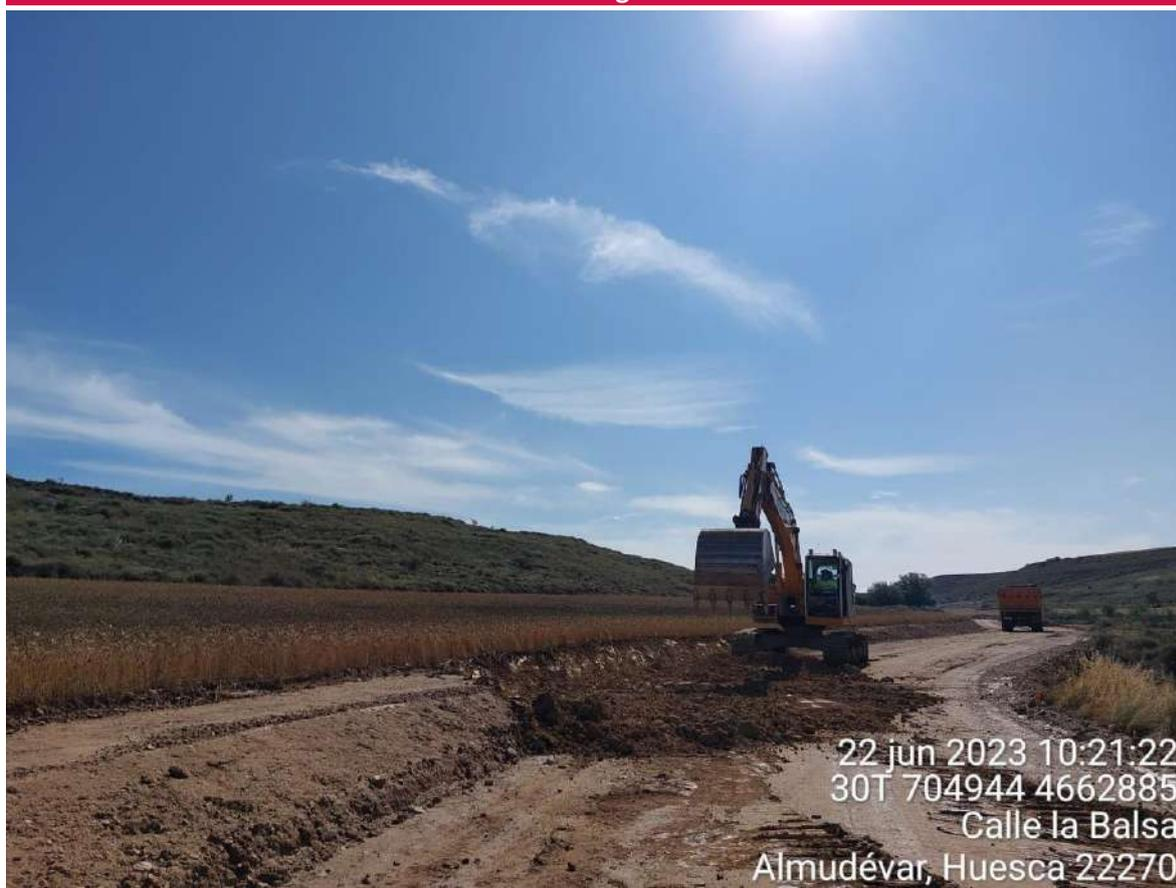
Imagen 2. Movimientos de tierra en vial hacia los aerogeneradores 7 y 8.
