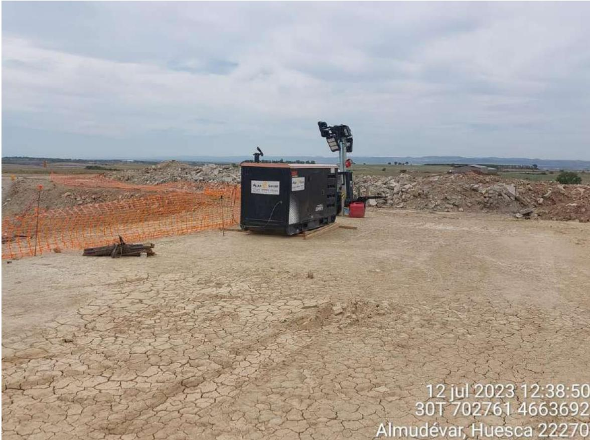
Imagen 2. Grupo electrógeno sin protección del suelo.
