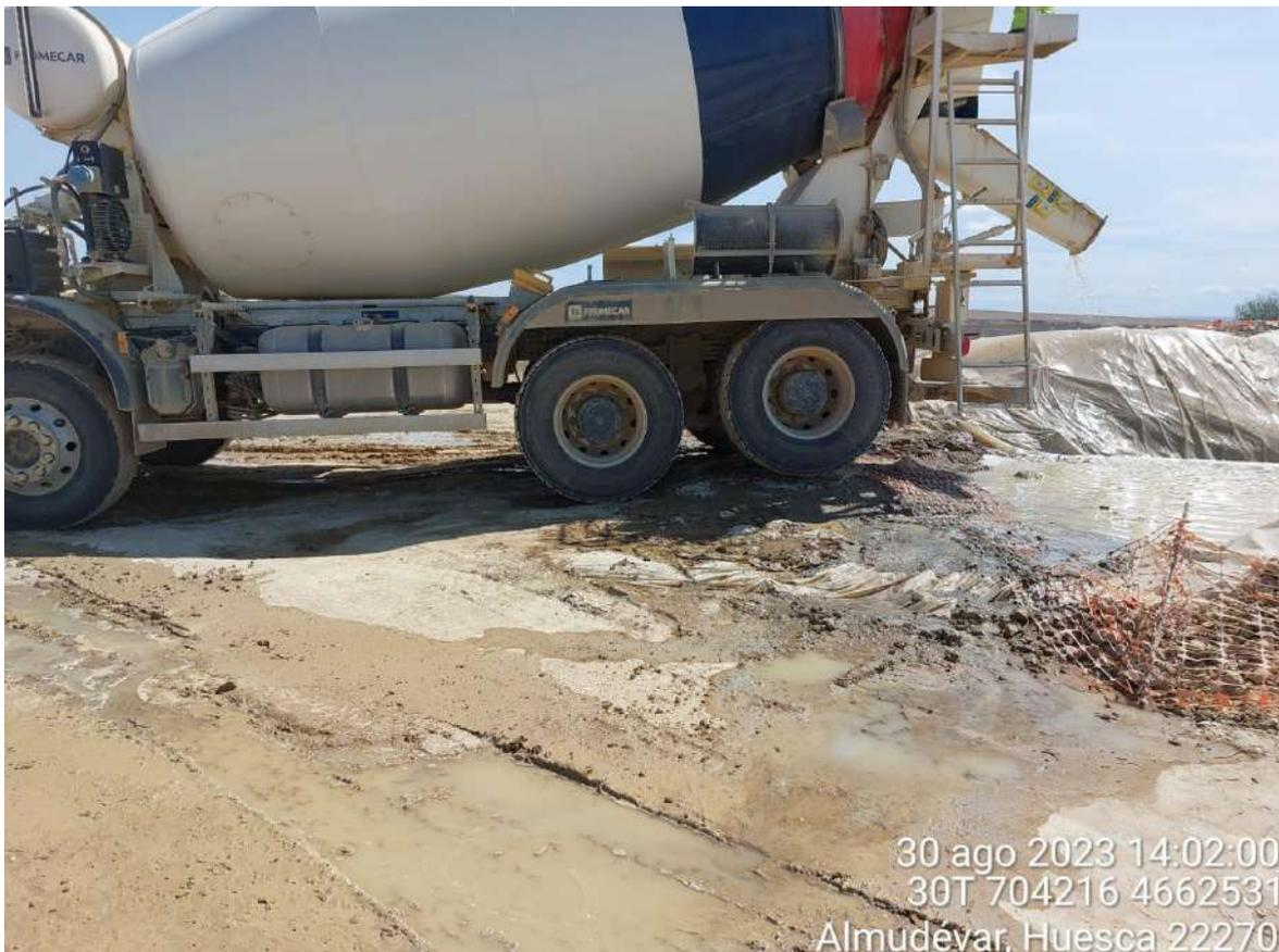
Imagen 2. No conformidad leve debido al desbordamiento del pozo de lavado de SIS-04.
