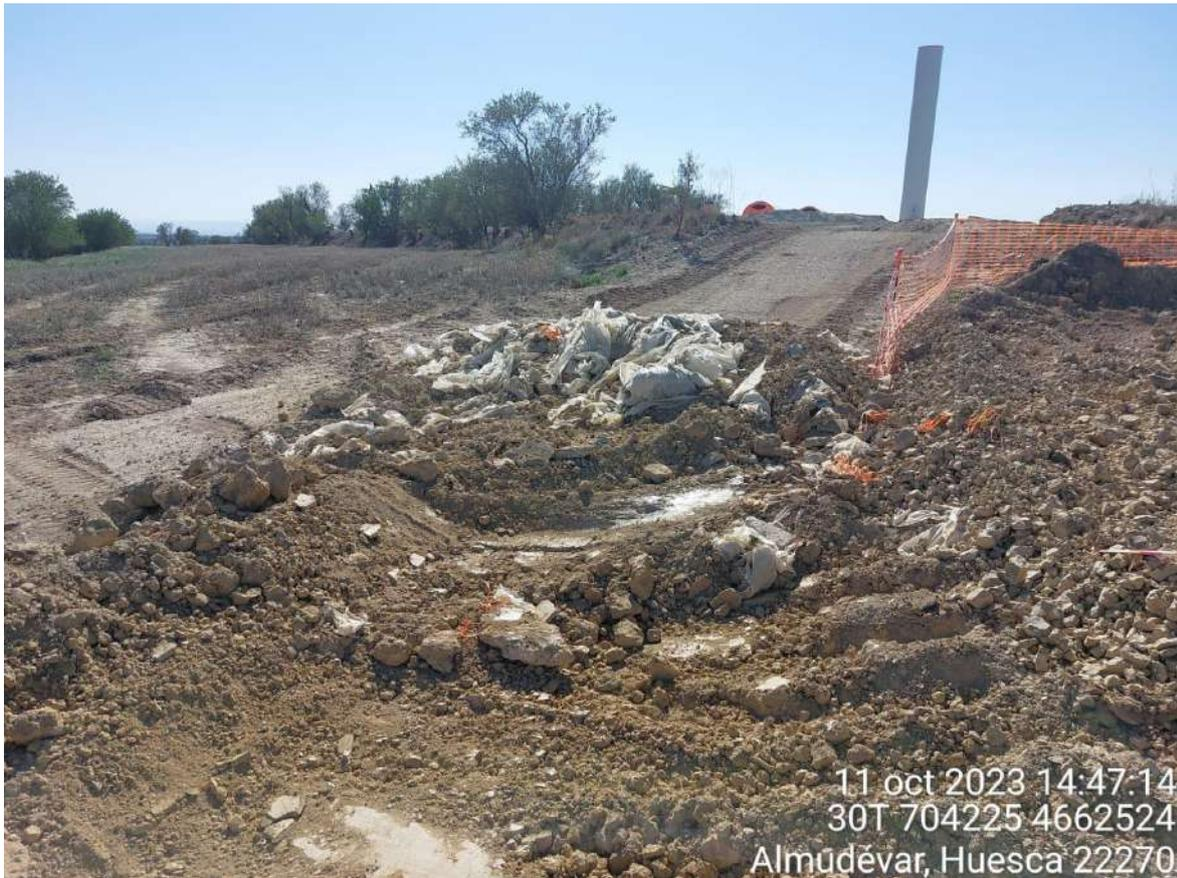
Imagen 2. No conformidad leve. Pozo de lavado de SIS-04 mal restaurado con plásticos, hormigón y balizas mezcladas con la tierra que ha tapado el agujero.
