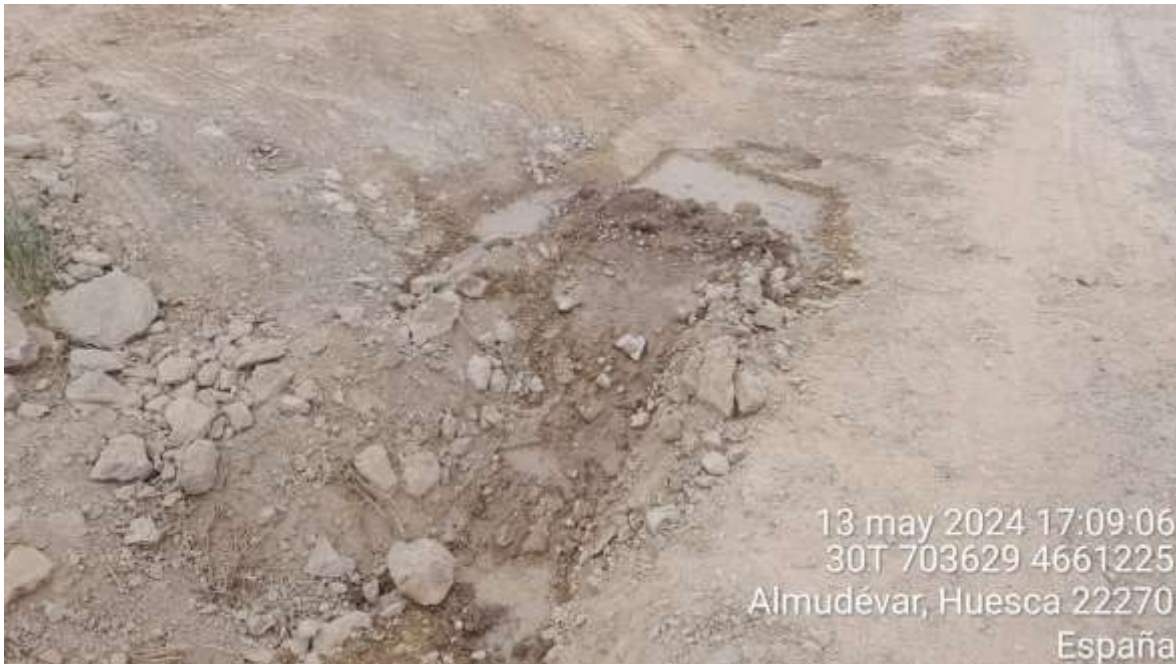
Imagen 1. NC grave debido a la limpieza de la canaleta de hormigón en zona no habilitada.
