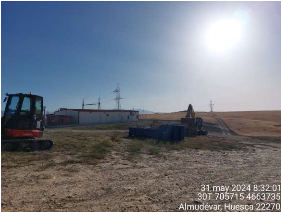
Imagen 1. Últimos trabajos en SET, retirada de casetas y de contenedores
