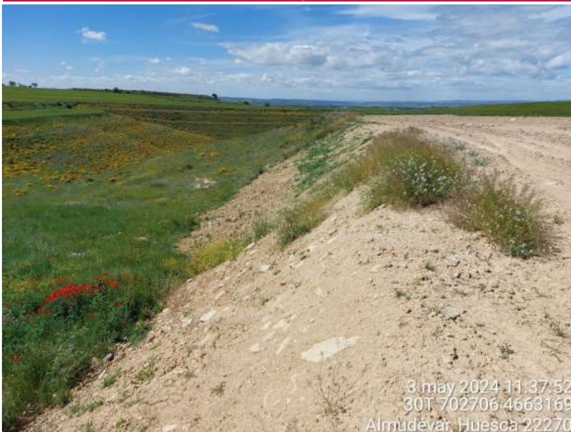
Imagen 1. Estado de la hidrosiembra en la zona de la TM varias semanas después de su ejecución.
