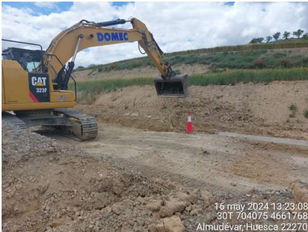
Imagen 2. Maquinaria realizando trabajos de reperfilado de taludes y de odt.
