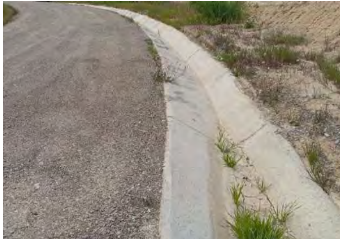
Fotografía 14: Drenajes del parque
