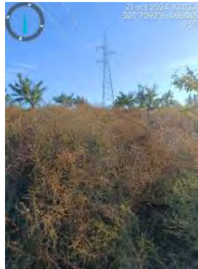
Fotografías 33: Maleza en acceso a la línea
