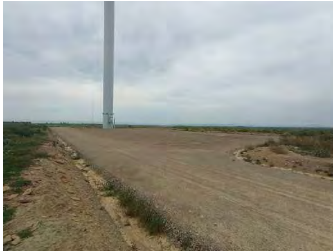
Fotografía 12: Plataformas de los aerogeneradores
