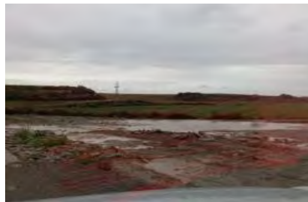
Fotografía 34: Caminos embarrados en acceso a la línea por las lluvias
