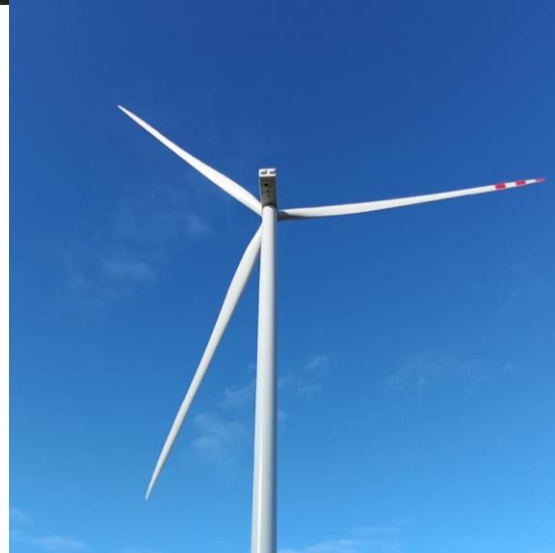
Fotografía 3: Palas pintadas a franjas
