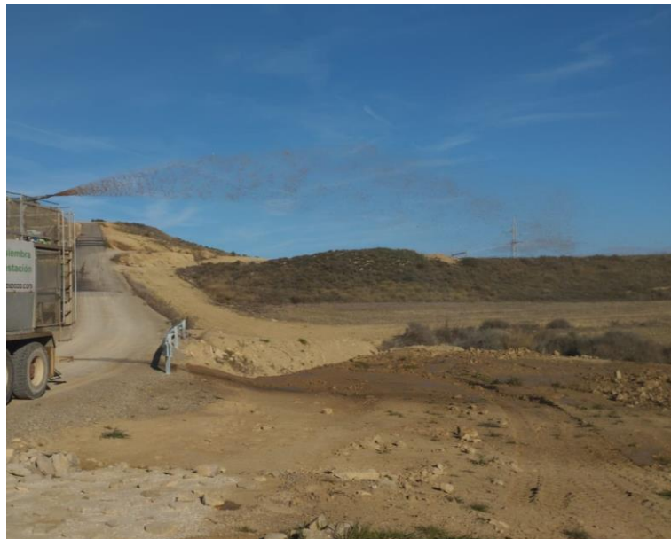
Fotografías 21 a 24: Labores de hidrosiembra en el mes de diciembre
