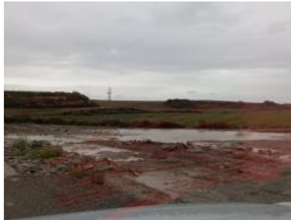
Fotografía 48: Caminos embarrados en acceso a la línea por las lluvias
