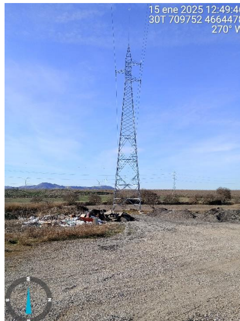
Fotografía 45: Residuos urbanos y de construcción ajenos a las instalaciones
