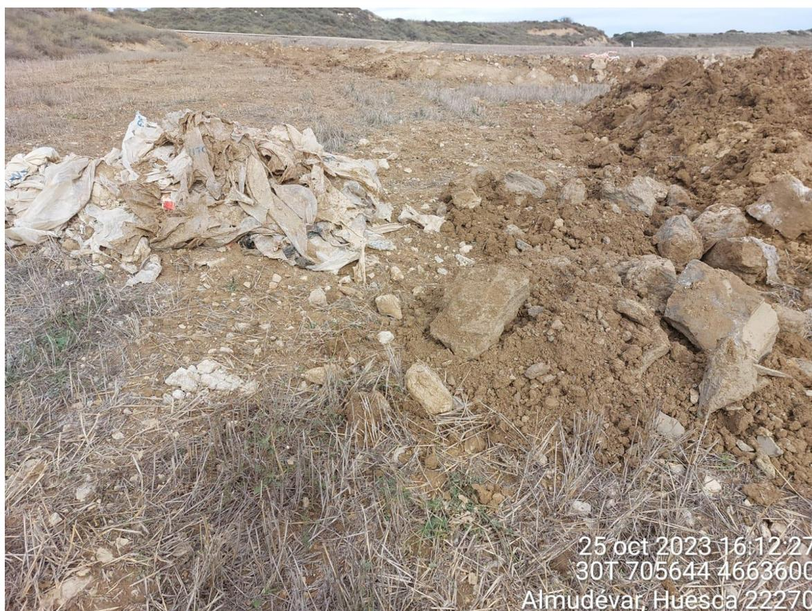
Imagen 1. No conformidad muy grave. Plásticos y hormigón enterrados bajo el pozo de lavado en SIS-06.
