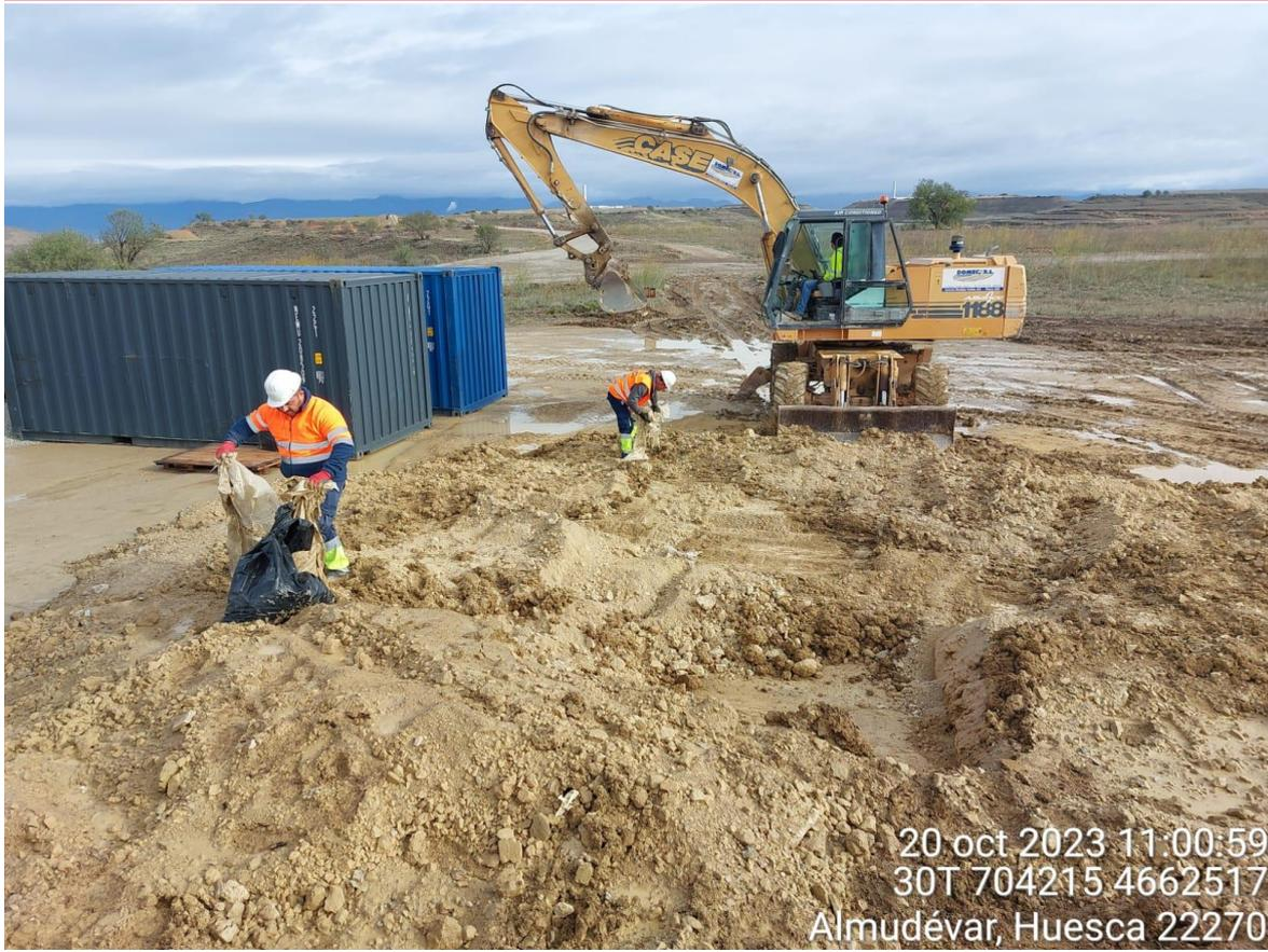
Imagen 2. Plástico, restos de material utilizado para balizar etc enterrado bajo el pozo de lavado restaurado.
