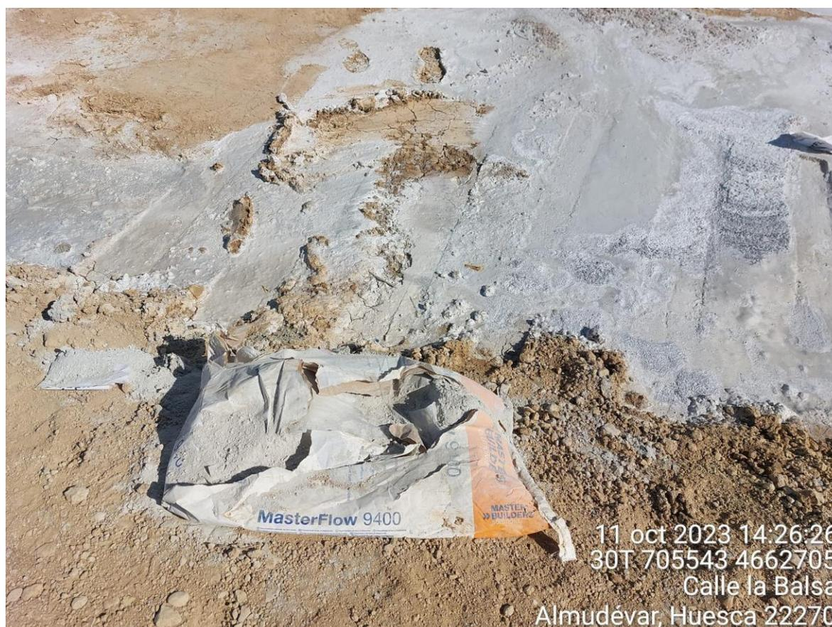
Imagen 3. No conformidad leve. Cemento en una elevada superficie en SIS-08
