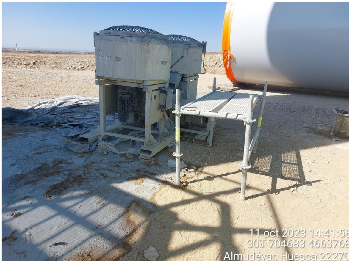
Imagen 4. No conformidad leve. Hormigón en la plataforma de la posición SIS-05 sin protección del suelo.
