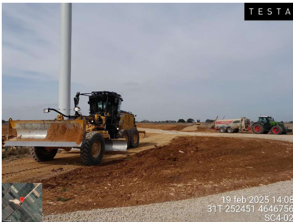
Imagen 1. Trabajos de restauración en SC4-02
