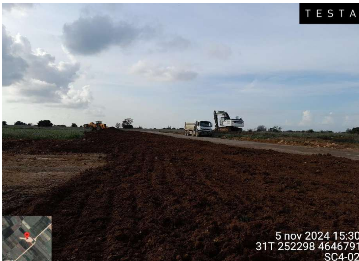
Imagen 2. Extendido de tierra vegetal durante los trabajos de restauración en la posición SC4-02
