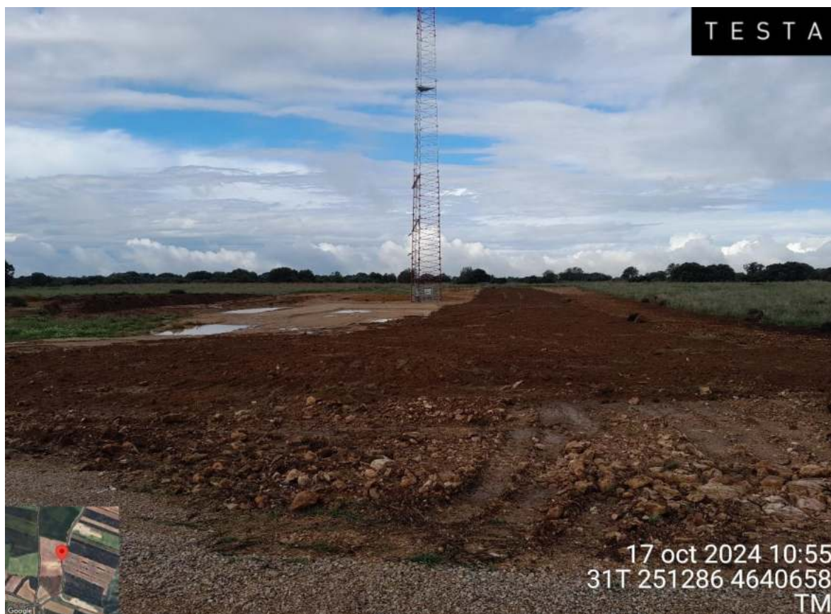
Imagen 2. Restauración de la Torre Meteorológica
