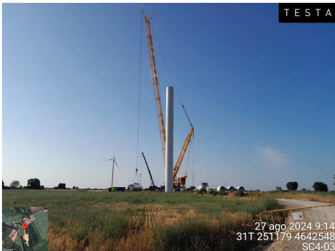
Imagen 2. Montaje de Aerogenerador en la posición SC4-03
