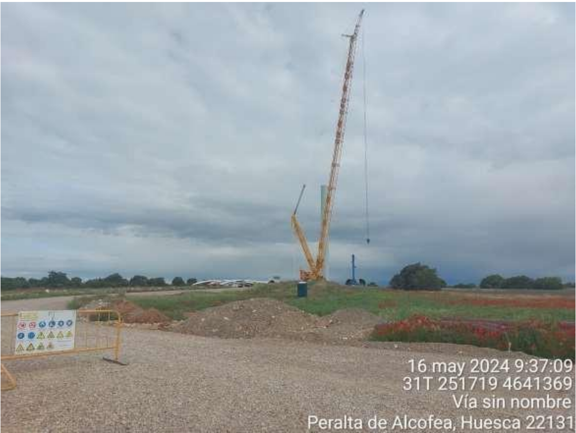
Imagen 1. Montaje del aerogenerador SIS2-03.
