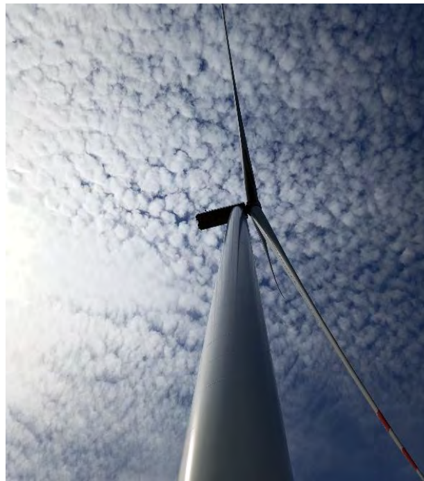
Fotografía 7: Barquilla de los aerogeneradores sin derrames
