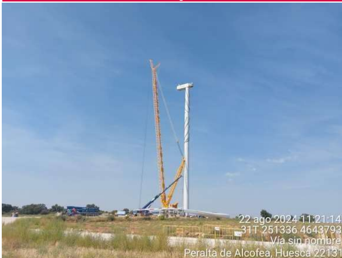
Imagen 1. Grúa principal preparada para montaje de palas en SC4-04.
