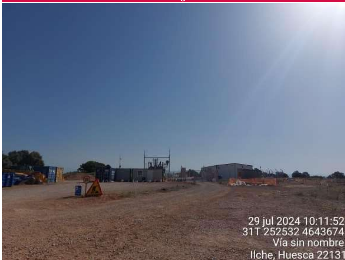
Imagen 1. Trabajos parados en SET SC4 debido a la alerta roja de incendios.
