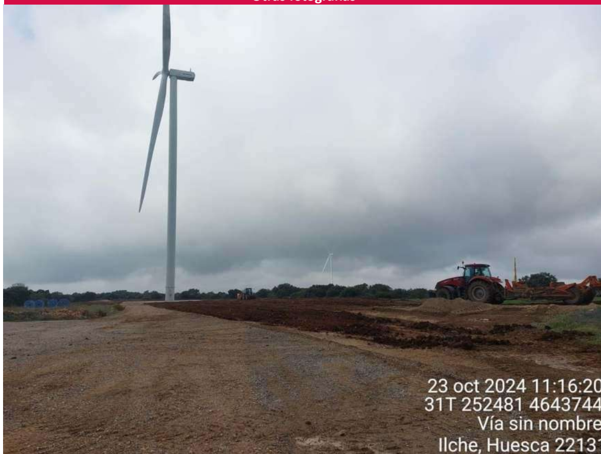
Imagen 1. Restauración ambiental en SIS2. Maquinaria trabajando en el movimiento de tierras.
