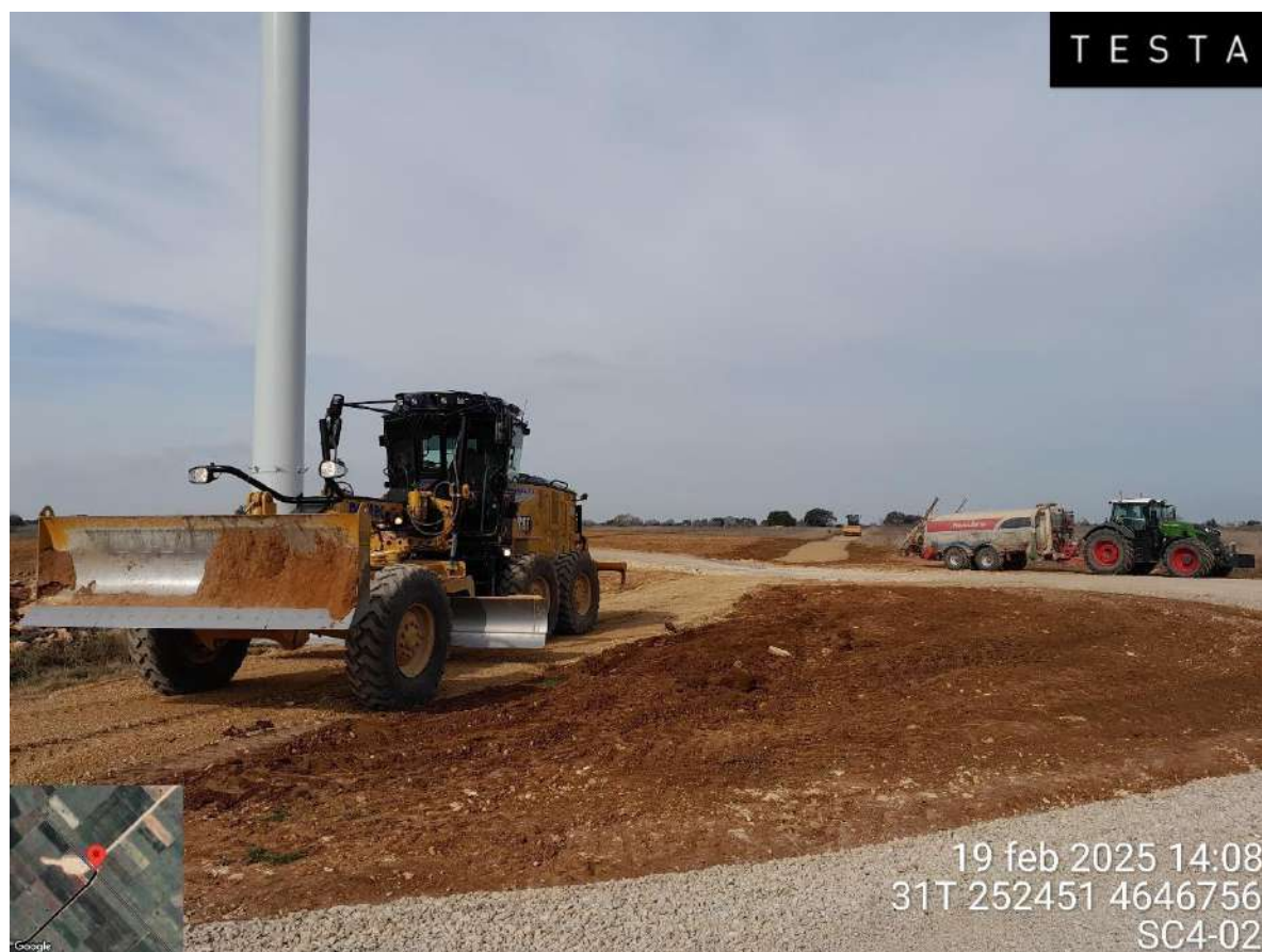
Imagen 1. Trabajos de restauración en SC4-02
