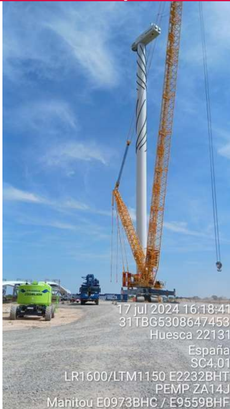
Imagen 1. SC4.01 Montaje principal de palas.
