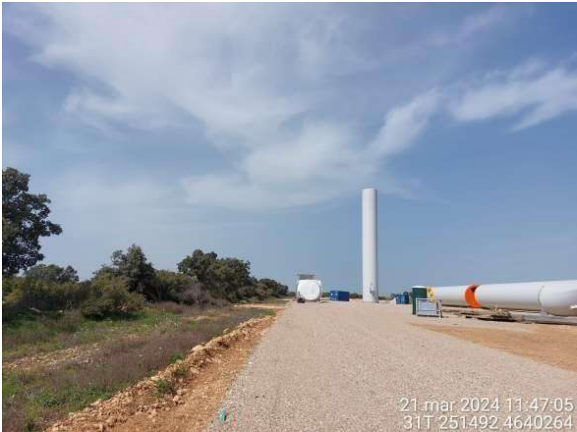
Ilustración 1. Montaje en SC3-03.
