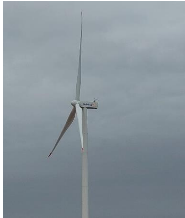
Fotos 9 y 10: Aerogeneradores con palas pintadas (medidas de innovación).
