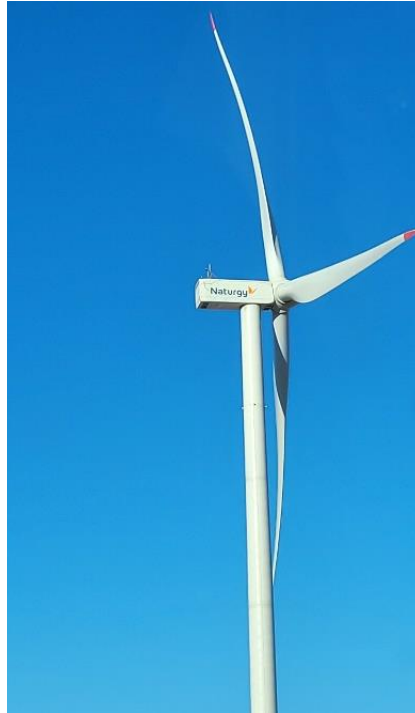
Fotos 9 y 10: Aerogeneradores con palas pintadas (medidas de innovación).
