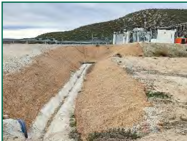
Fotografía 38. Talud de escorrentía de la SET, con la malla de fibra de coco.
