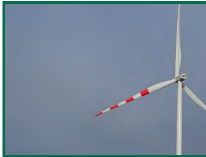
Fotografía 29. Pintado de cuatro franjas en una pala.
