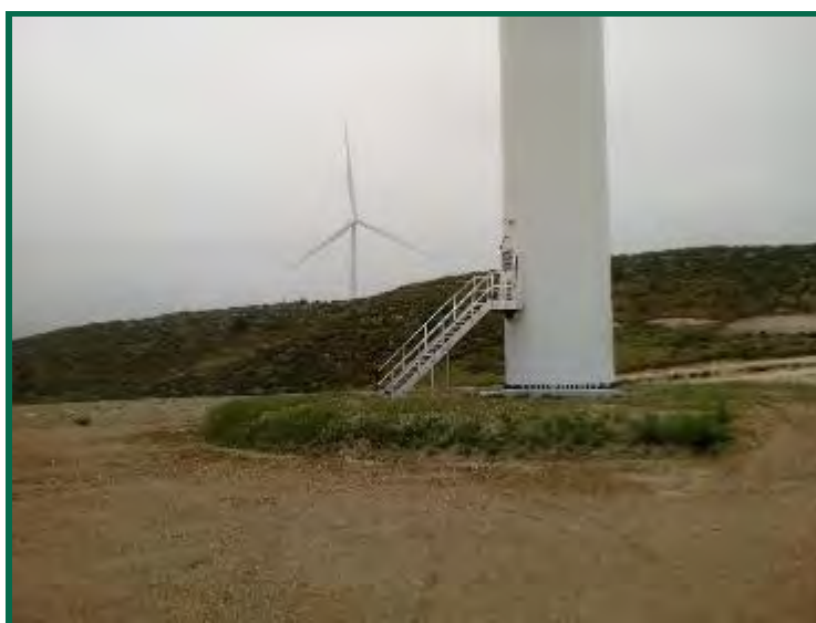
Fotografía 44. Talud de la plataforma, hidrosemebrado.
