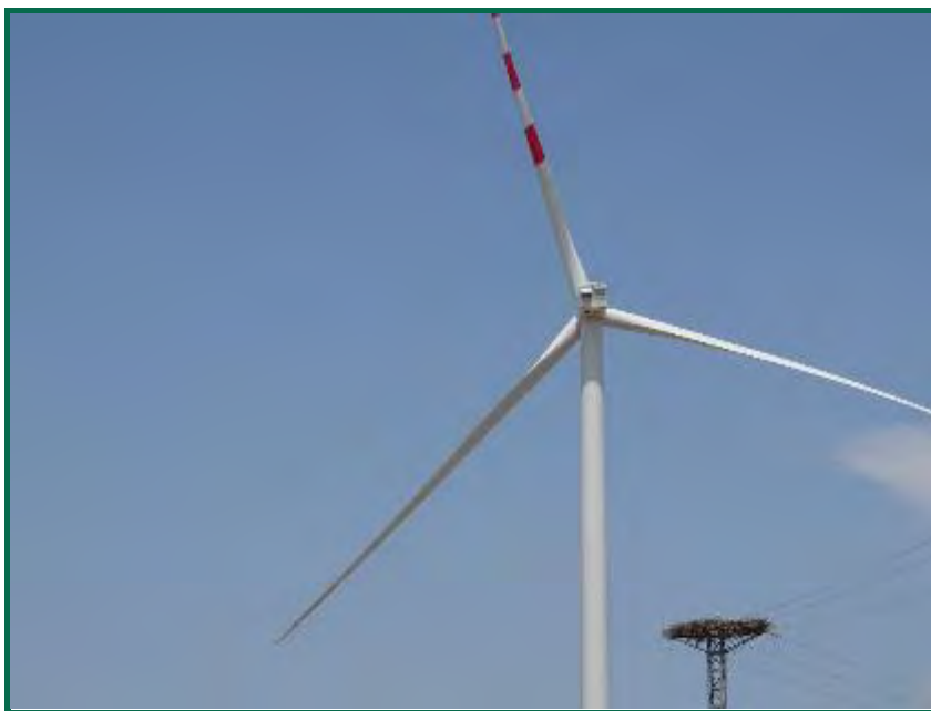
Fotografía 34. Marcaje de pala con tres bandas rojas, en ROII-01.
