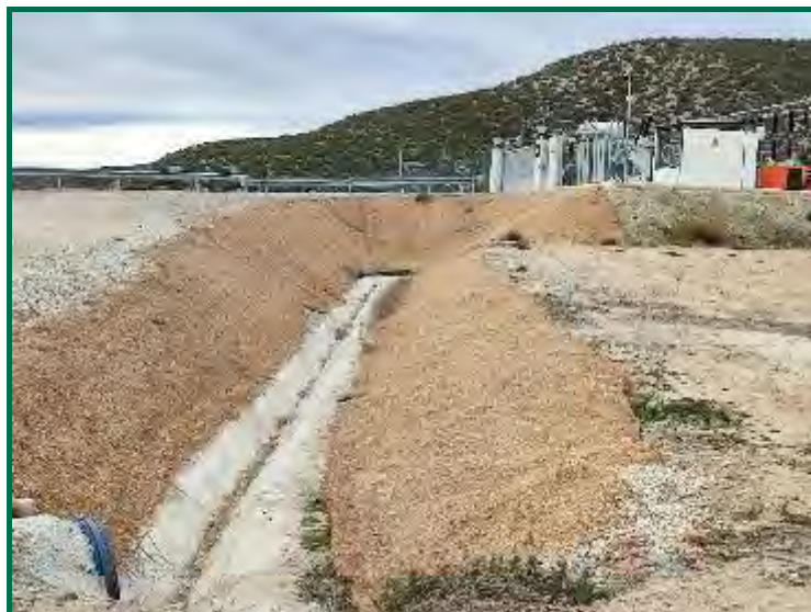
Fotografía 41. Talud de escorrentía de la SET, con la malla de fibra de coco.
