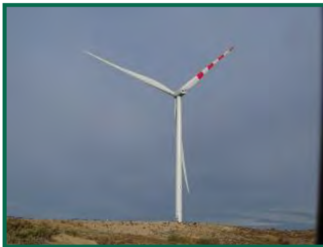
Fotografía 29. Pintado de cuatro franjas en una pala, ROII-01.
