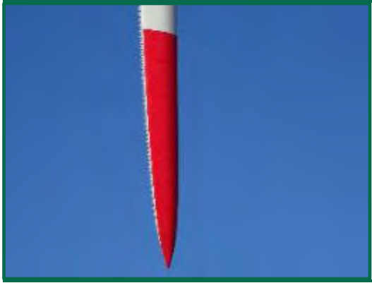
Fotografía 28. Pintado punta de las palas
