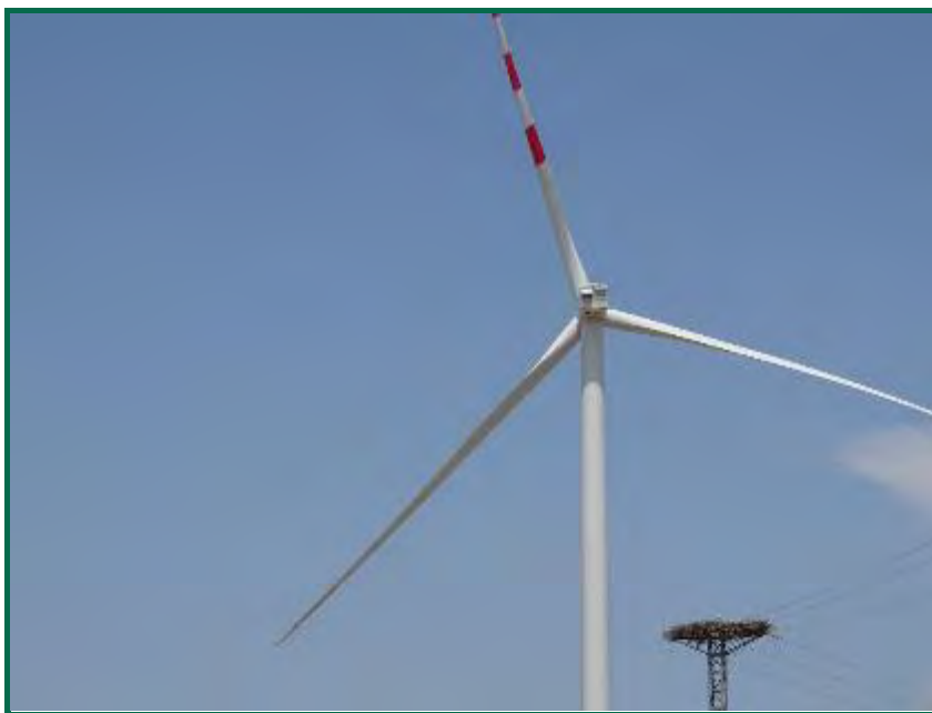
Fotografía 39. Marcaje de pala con tres bandas rojas, en ROII-01.
