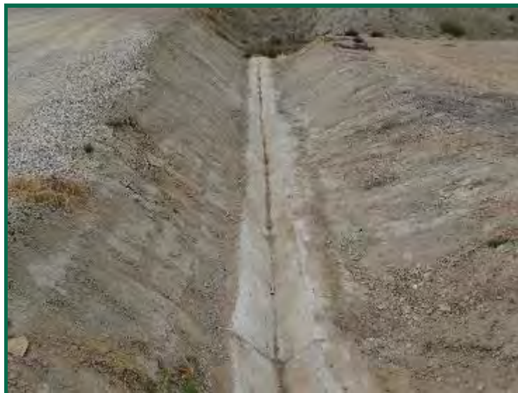
Fotografía 42. Talud de escorrentía de la SET, aplanado.
