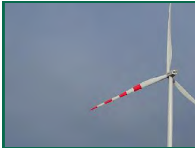
Fotografía 30. Pintado de cuatro franjas en una pala.
