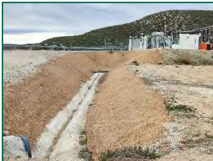
Fotografía 43. Talud de escorrentía de la SET, con la malla de fibra de coco.
