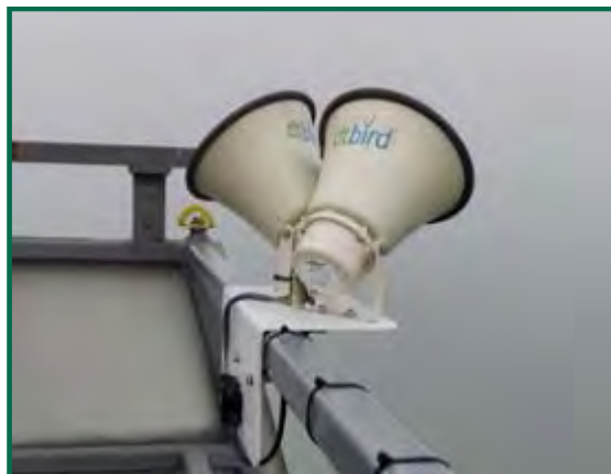
Fotografía 37. Sistema de anclaje de los altavoces.
