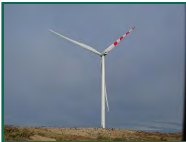
Fotografía 31. Pintado de cuatro franjas en una pala, ROII-01.
