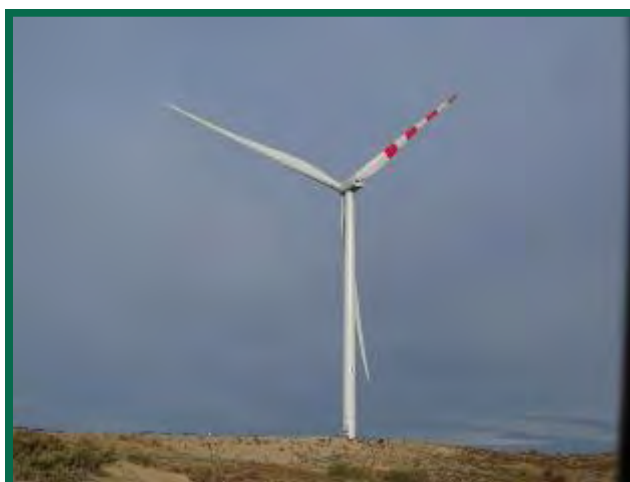
Fotografía 35. Pintado de cuatro franjas en una pala, ROII-01.
