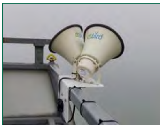
Fotografía 41. Sistema de anclaje de los altavoces.
