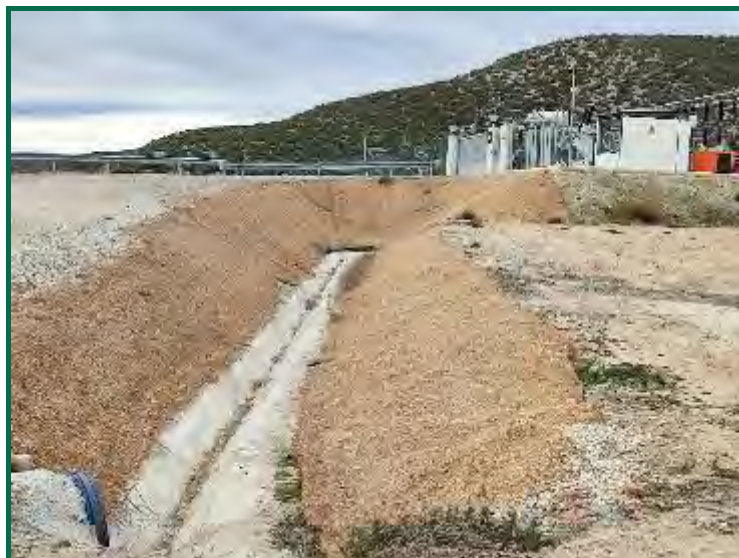
Fotografía 47. Talud de escorrentía de la SET, con la malla de fibra de coco.
