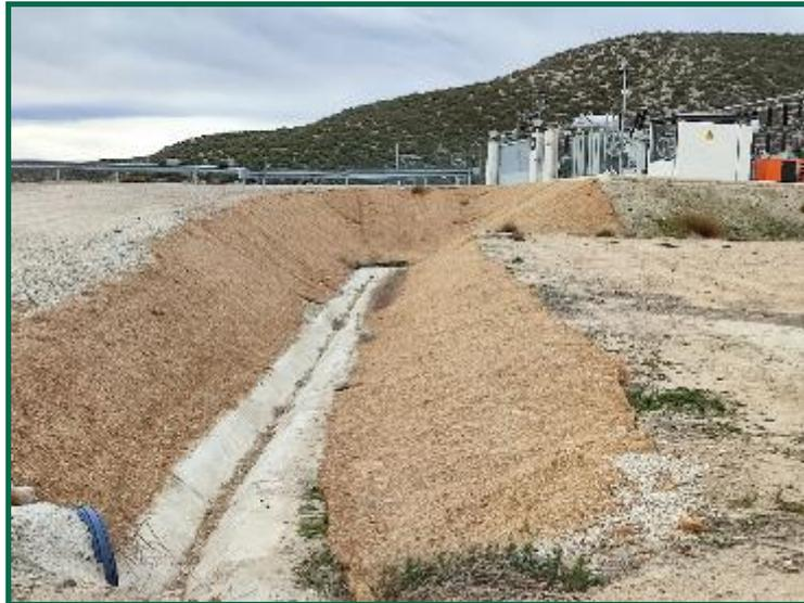
Fotografía 45. Talud de escorrentía de la SET, con la malla de fibra de coco.
