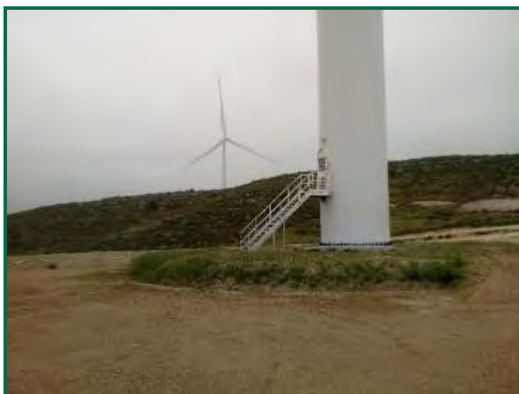
Fotografía 28. Talud de la plataforma, hidrosemebrado.
