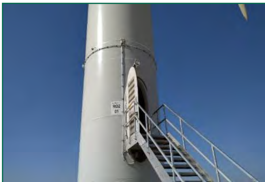
Fotografía 19. Nuevo sistema W4-D10, instalado.
