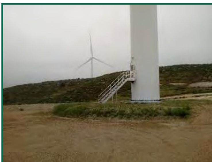
Fotografía 32. Talud de la plataforma, hidrosemebrado.
