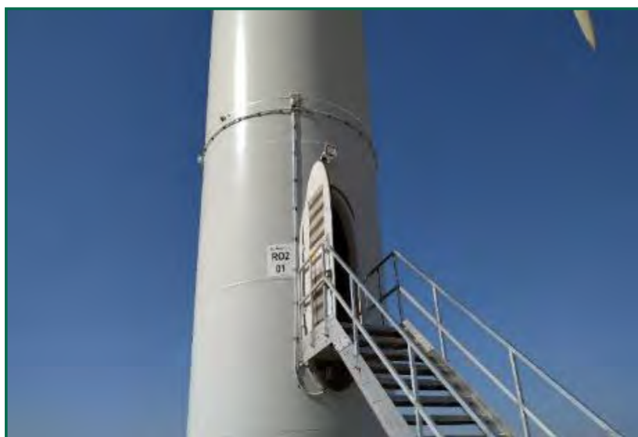
Fotografía 23. Nuevo sistema W4-D10, instalado.
