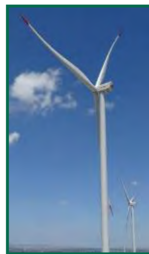
Fotografía 22. Pintado de palas en los aerogeneradores.
