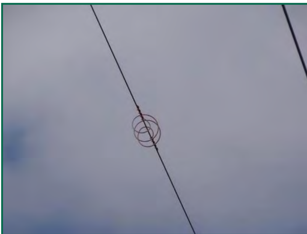
Fotografía 2. Detalle de balizas salvapájaros.
