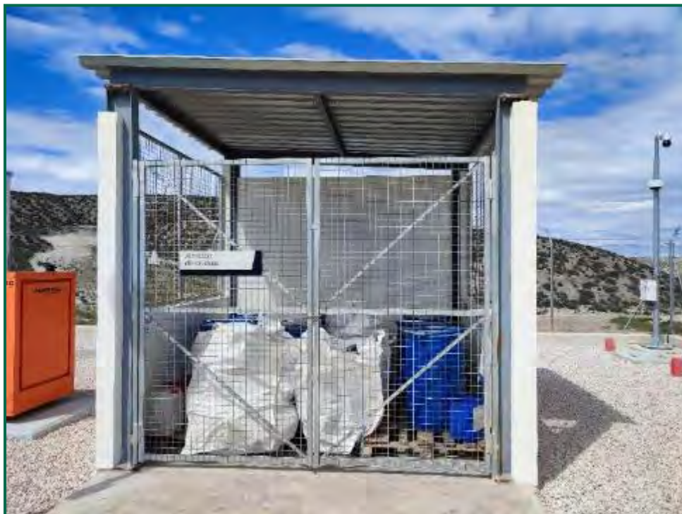
Fotografía 53. Almacén de residuos para gestor autorizado.
