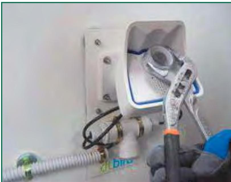
Fotografía 24. Cubrelente acoplado a la nueva cámara.
