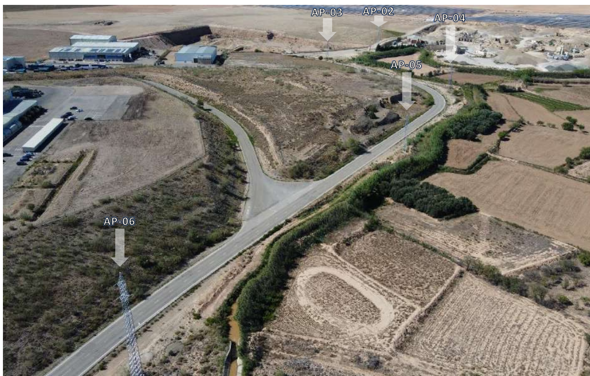
Foto nº5.: Vista aérea: Apoyo nº 2, Apoyo nº 3, Apoyo nº 4, Apoyo nº 5 y Apoyo nº 6 de la LAAT.
