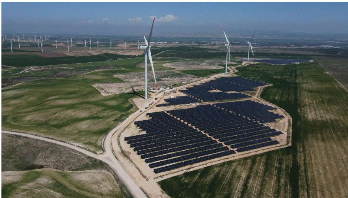
Foto nº1.: Vista aérea del Parque eólico Río Ebro II.
