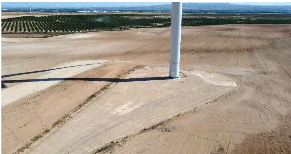
Foto nº3.: Plataforma del Aerogenerador REII-03.
