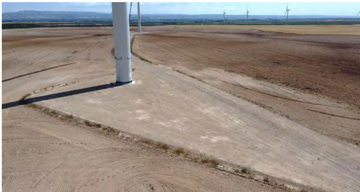
Foto nº1.: Plataforma del Aerogenerador REII-01.
