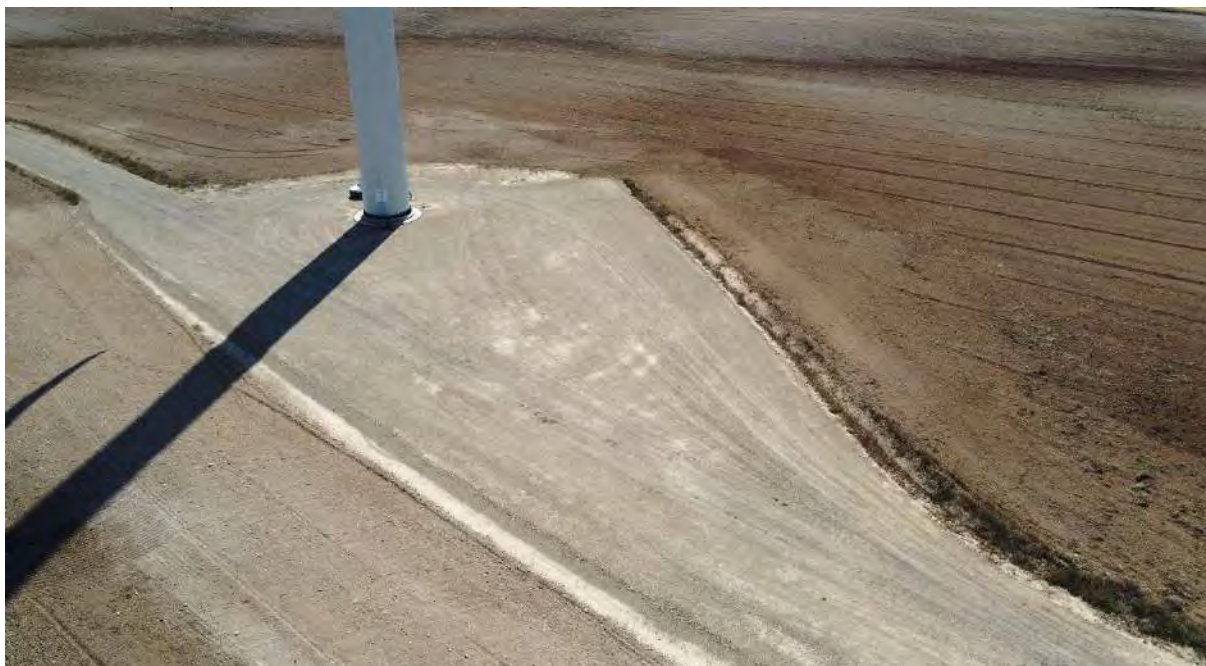
Foto nº2.: Plataforma del Aerogenerador REII-02.
