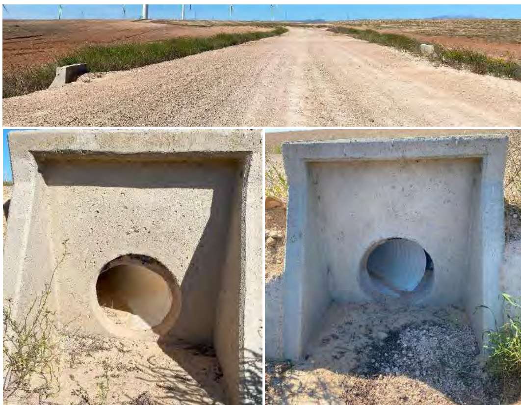
Foto nº7.: Drenaje de vial.
