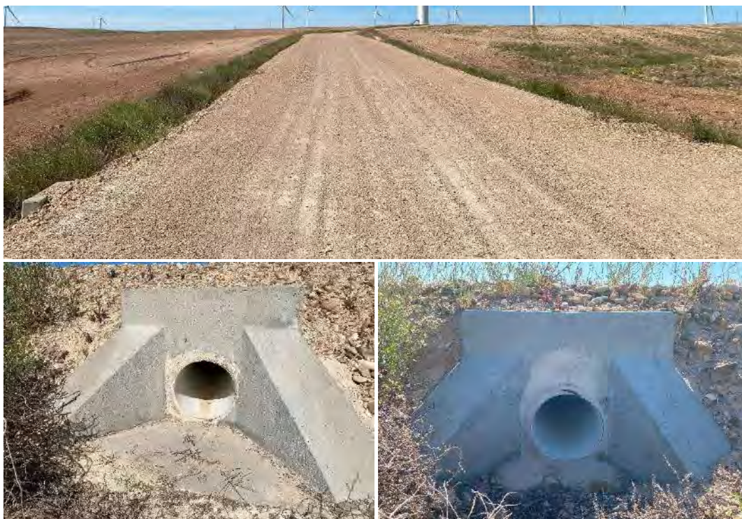
Foto nº6.: Drenaje de vial.
