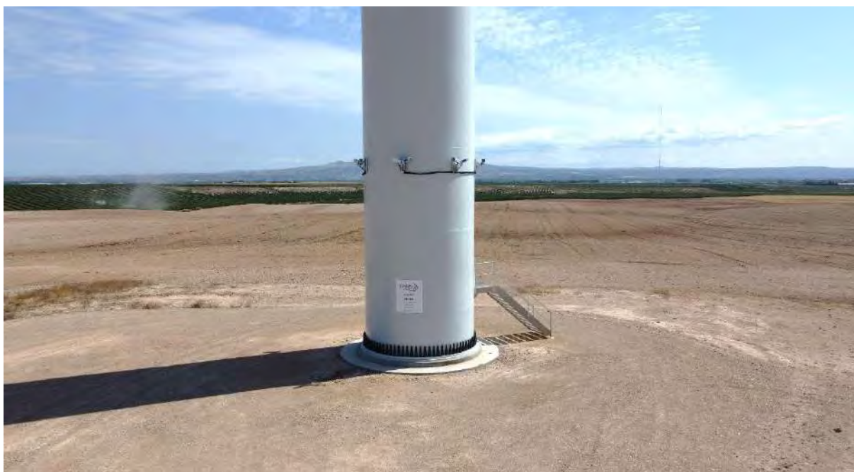
Foto nº4.: Instalación Dispositivo 3DOBServer en Aerogenerador REII-03.
