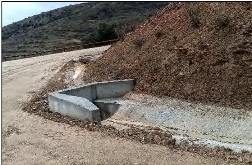
**Fotografía 2.** Acondicionamiento del sistema de drenaje en el vial de acceso a la turbina PDH03
