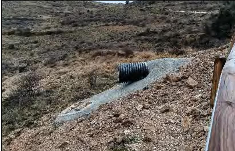
**Fotografía 1.** Actuaciones en el sistema de drenaje en el vial de acceso a la turbina PDH03 (17/02/2025)
