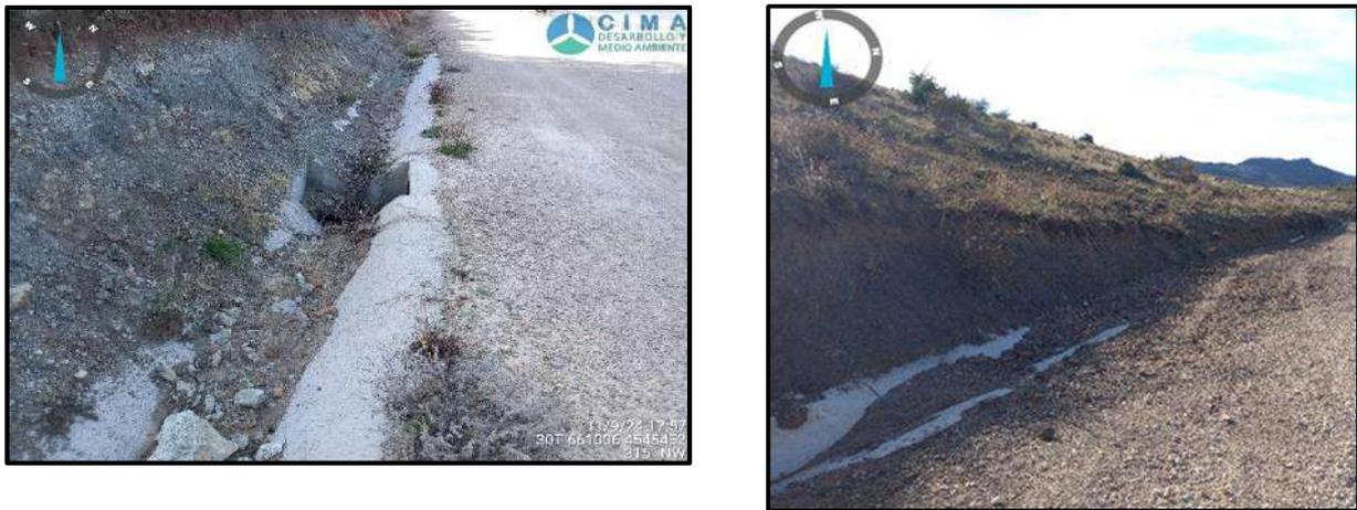
**Fotografía 2.** Ejemplo del estado de la cunetas tras los procesos de colmatación de sedimento fino y pequeñas piedras
