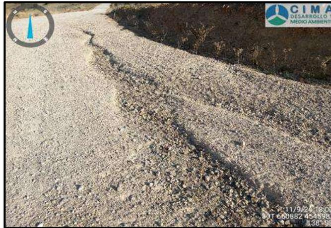
**Fotografía 4.** Ejemplo del estado de los viales afectados por la erosión debido a los eventos de intensa lluvia
