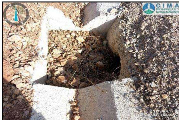
**Fotografía 3.** Ejemplo de paso de agua colmatados a lo largo del vial principal del parque eólico "Piedrahita"
