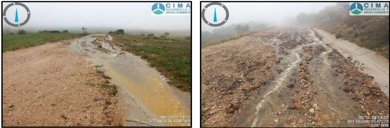
**Fotografía 1.** Ejemplos de sectores del vial afectados por el desbordamiento del sistema de drenaje
