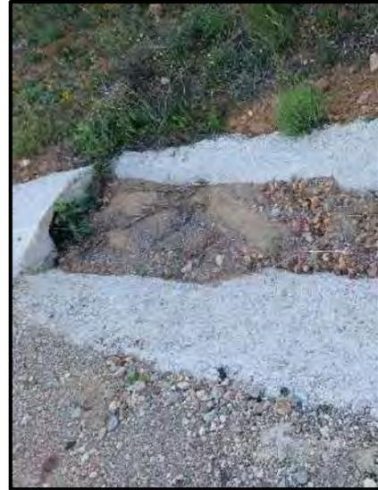
**Fotografía 2.** Ejemplos de cunetas y paso de agua colmatados a lo largo del vial principal del parque eólico “Piedrahita”
