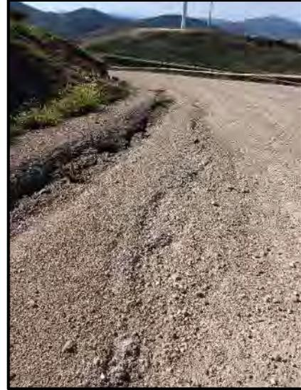
**Fotografía 1.** Ejemplos de procesos erosivos a lo largo del vial principal del parque eólico “Piedrahita”
