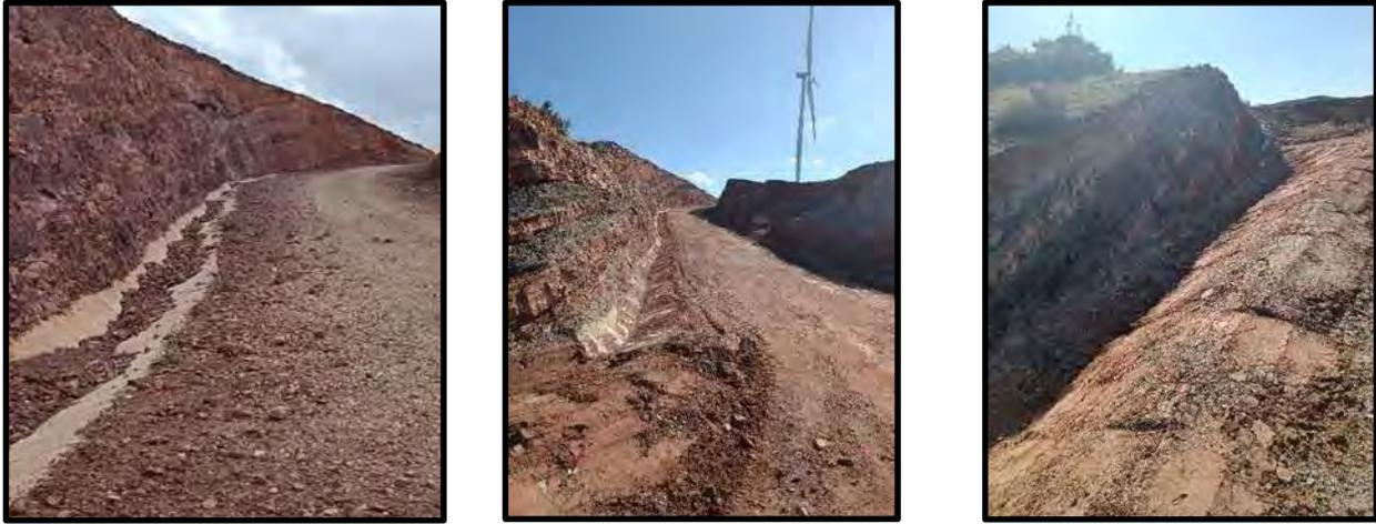
**Fotografía 10.** Trabajos de mantenimiento realizados en el vial de acceso a PDH01. Situación previa (izquierda) y tras la actuación (fotos central y derecha)
