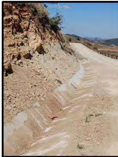
**Fotografía 5.** Cunetas del vial principal después de los trabajos de mantenimiento
